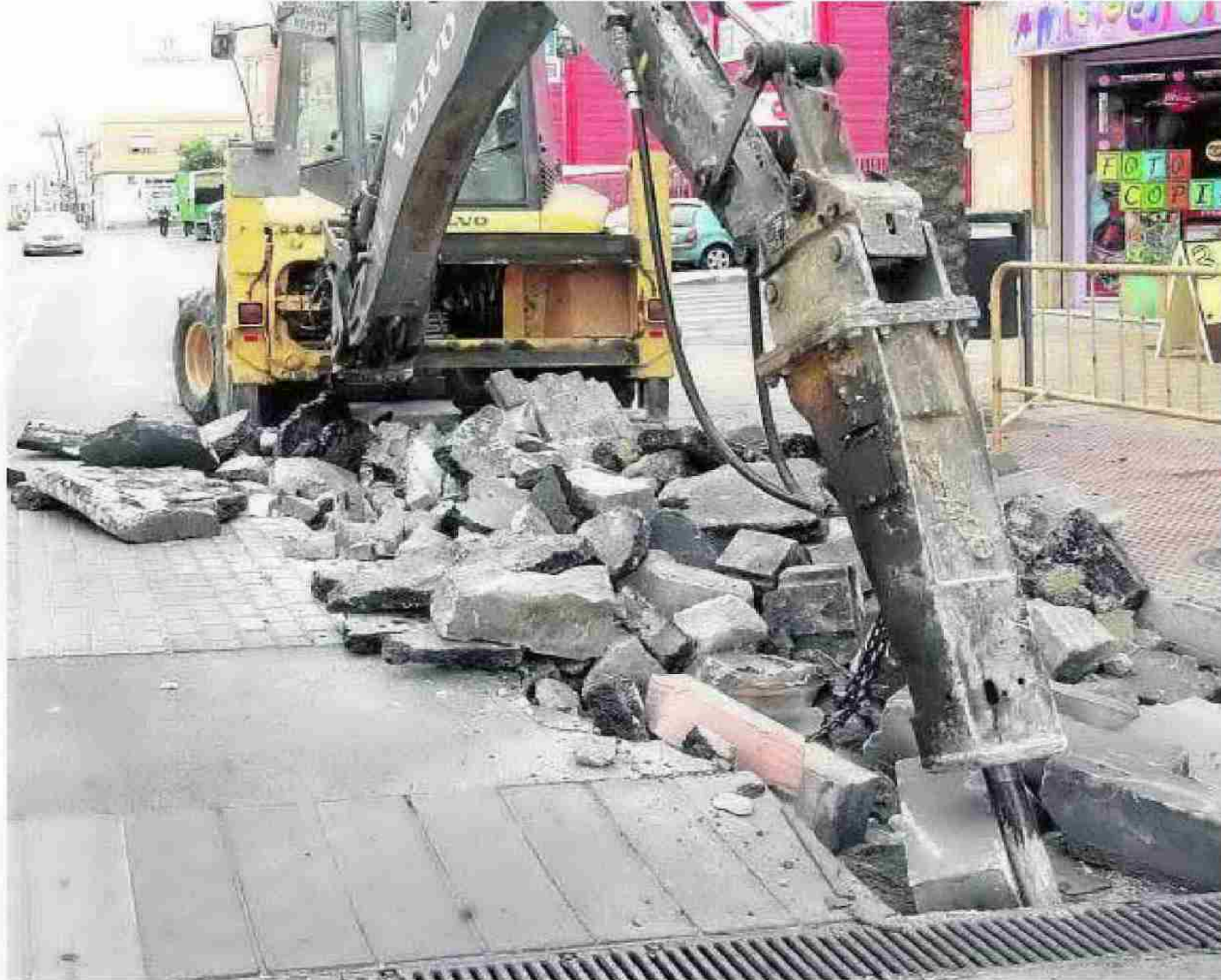
Una de las máquinas, en los trabajos que se llevan a cabo en La Cañada de San Urbano. :: J.J. MULLOR
