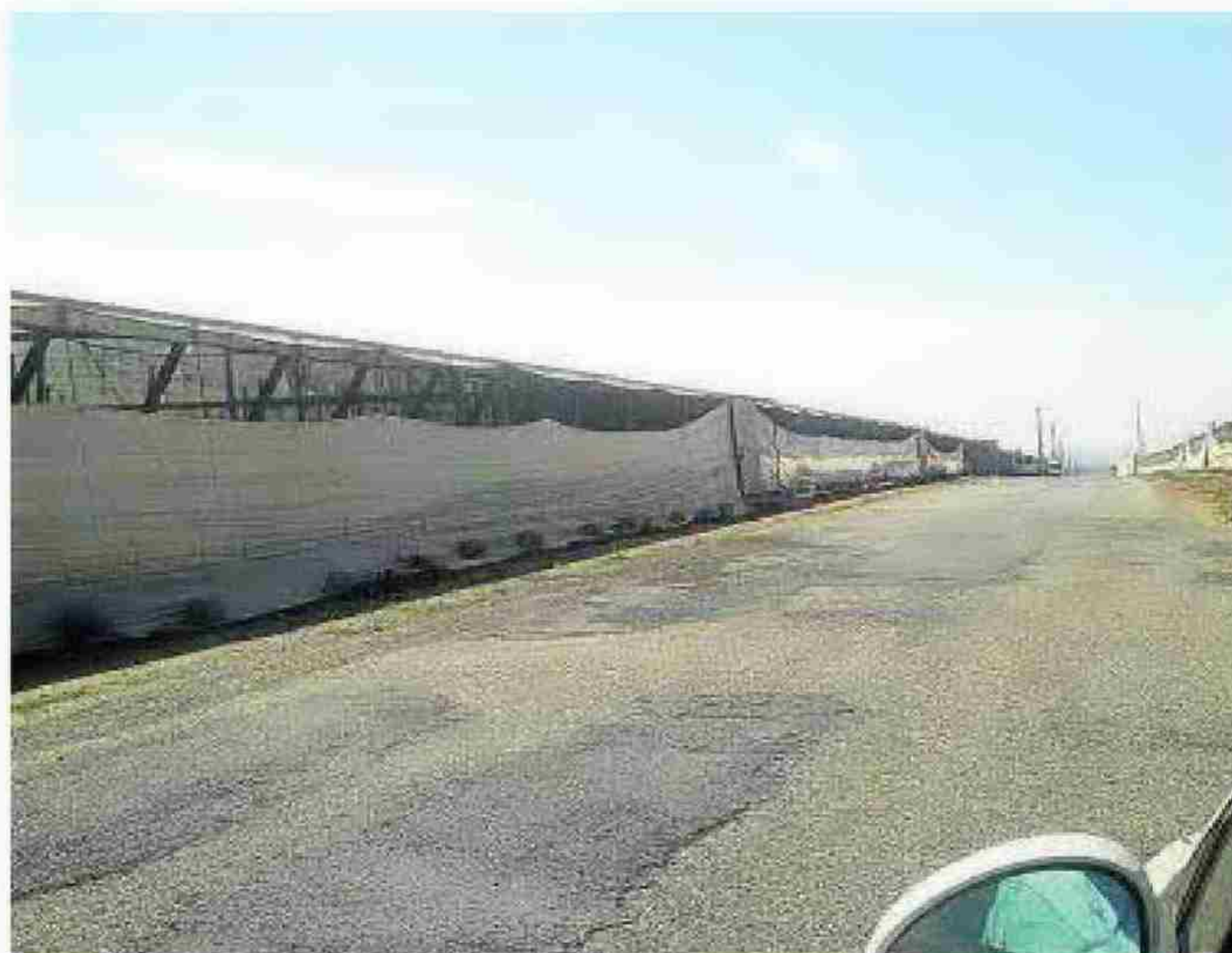
Asfaltado. Una de las vías que se mejorarán en La Mojonera. F. G.
