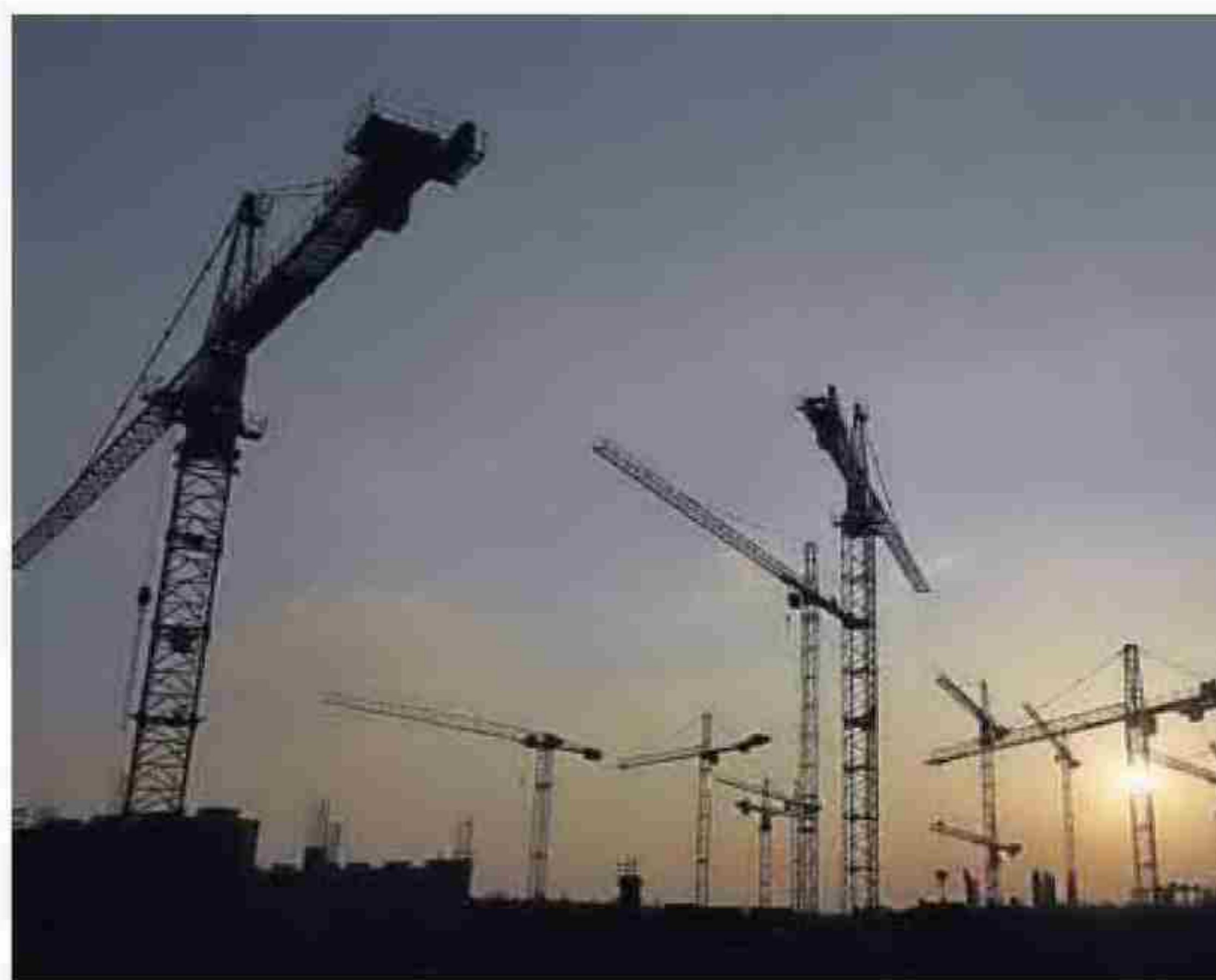
● Paisaje conquistado por grúas de la construcción. LA VOZ
