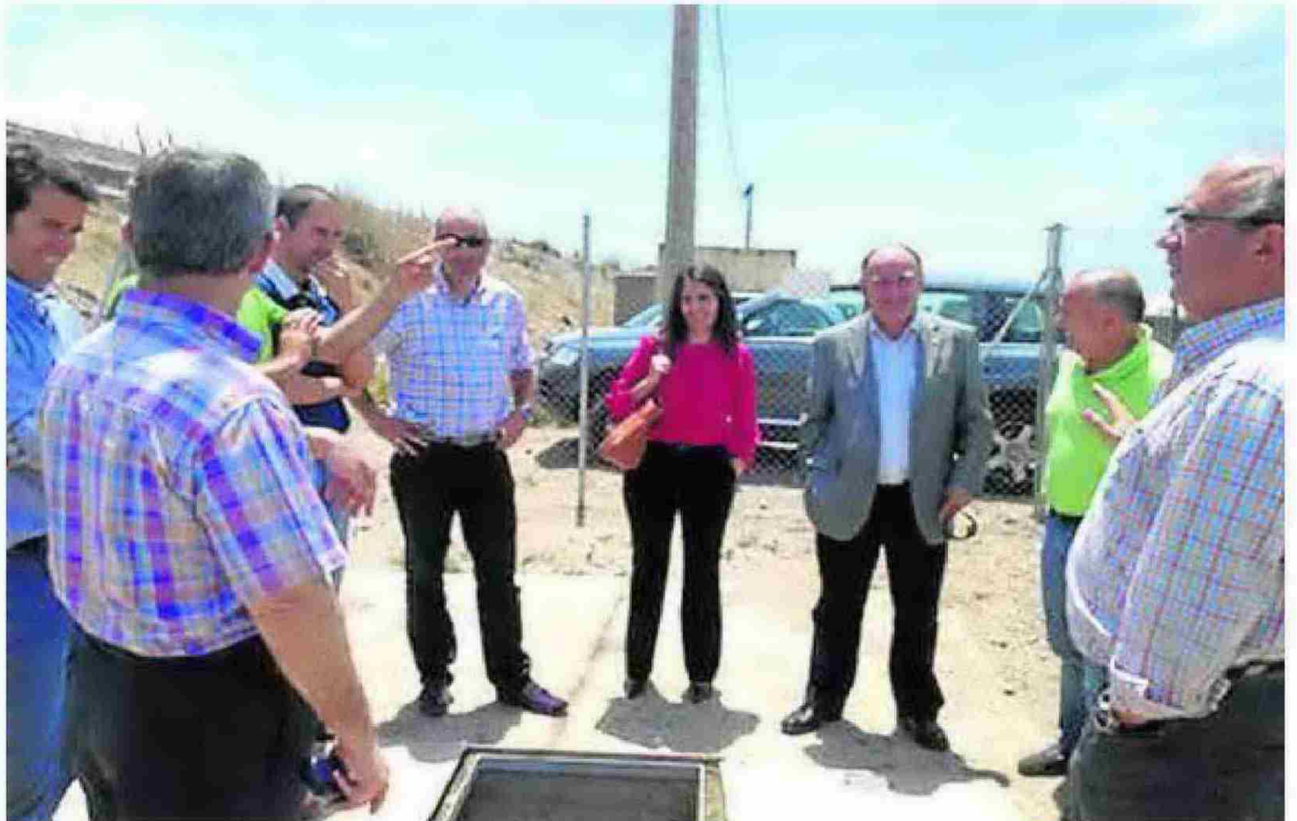
El alcalde ha visitado las obras junto a varios concejales y miembros del consorcio del Poniente.
