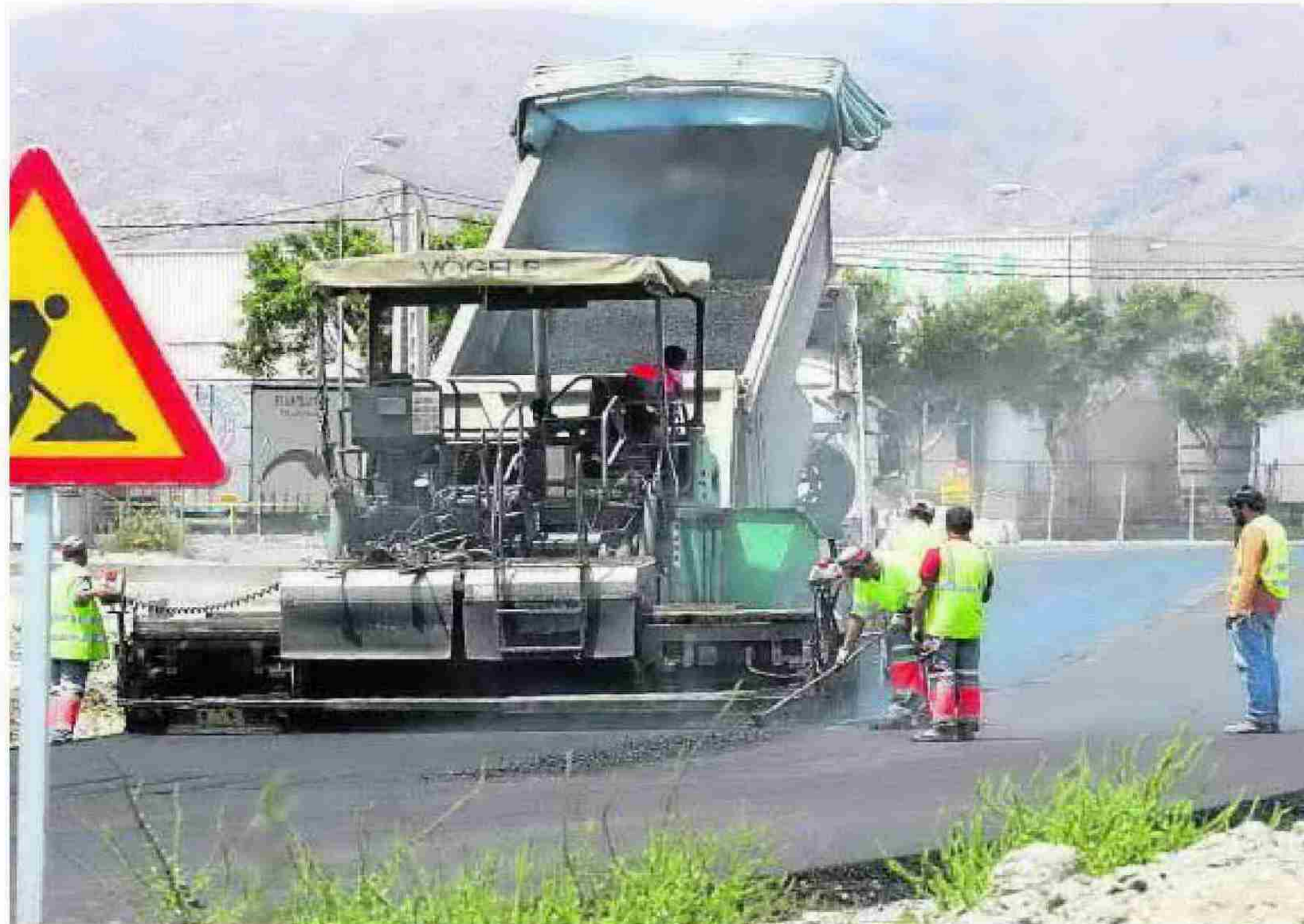
Operarios, ayer, en las labores de asfaltado de los actuales accesos a La Cañada. :: J.J. MULLOR
