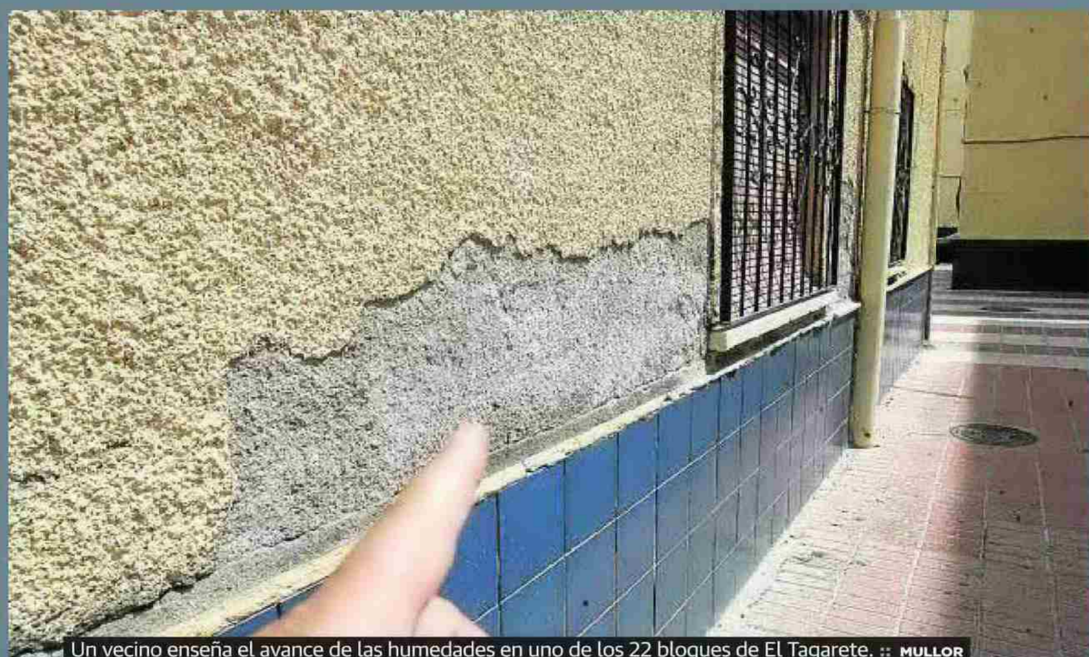
Un vecino enseña el avance de las humedades en uno de los 22 bloques de El Tagarete. :: MULLOR
