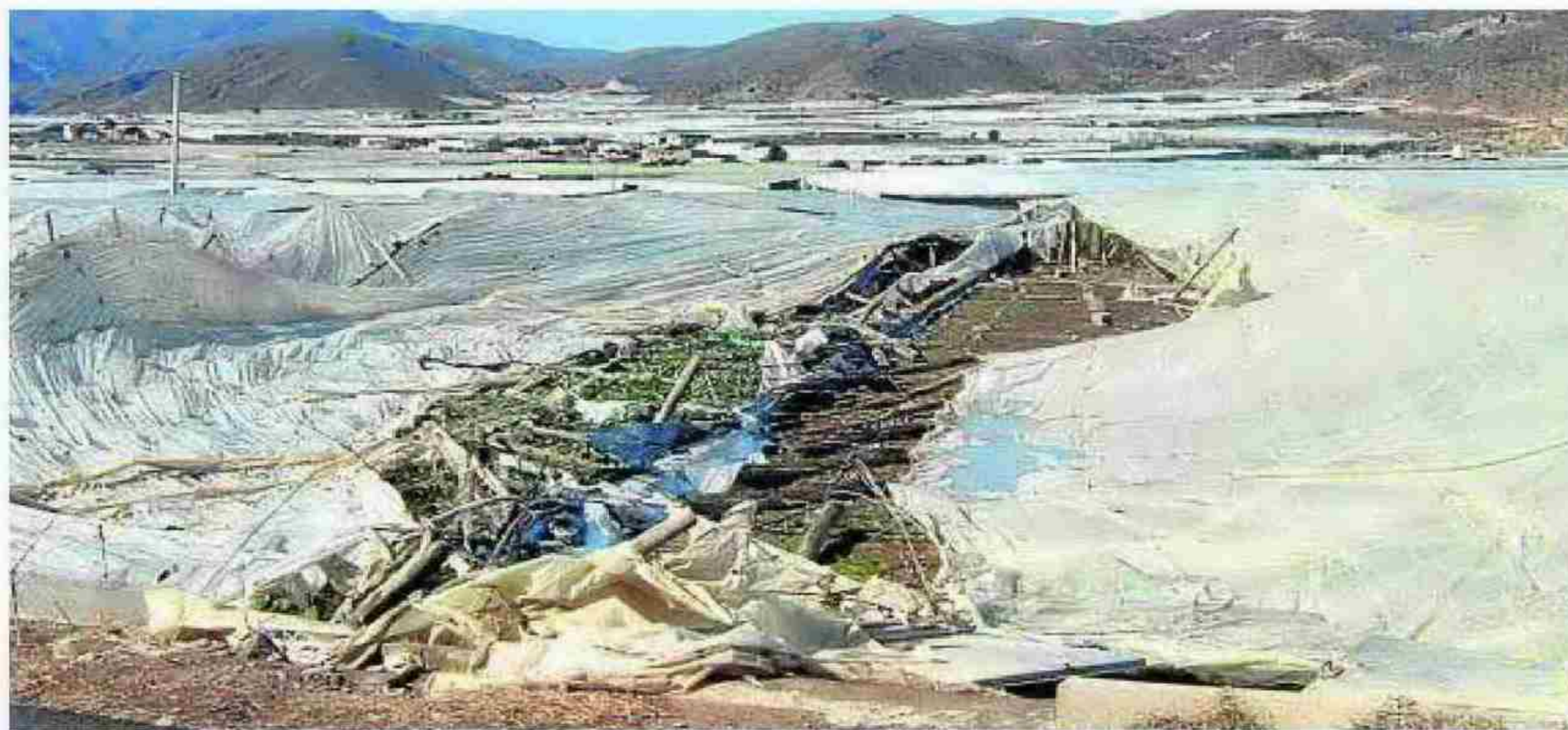
Daños. Invernaderos destrozados por el granizo y el viento acontecido al inicio de 2011. :: IDEAL
