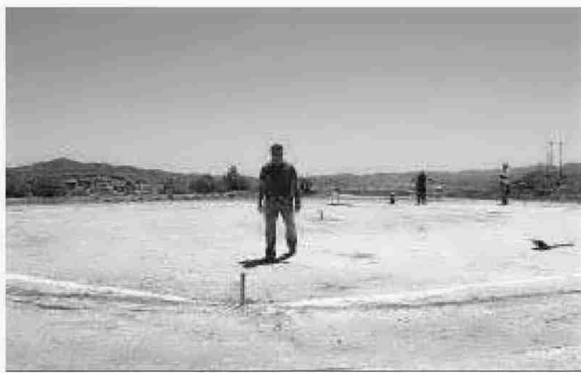
Las actuaciones llevadas a cabo en uno de los nuevos helipuertos.
