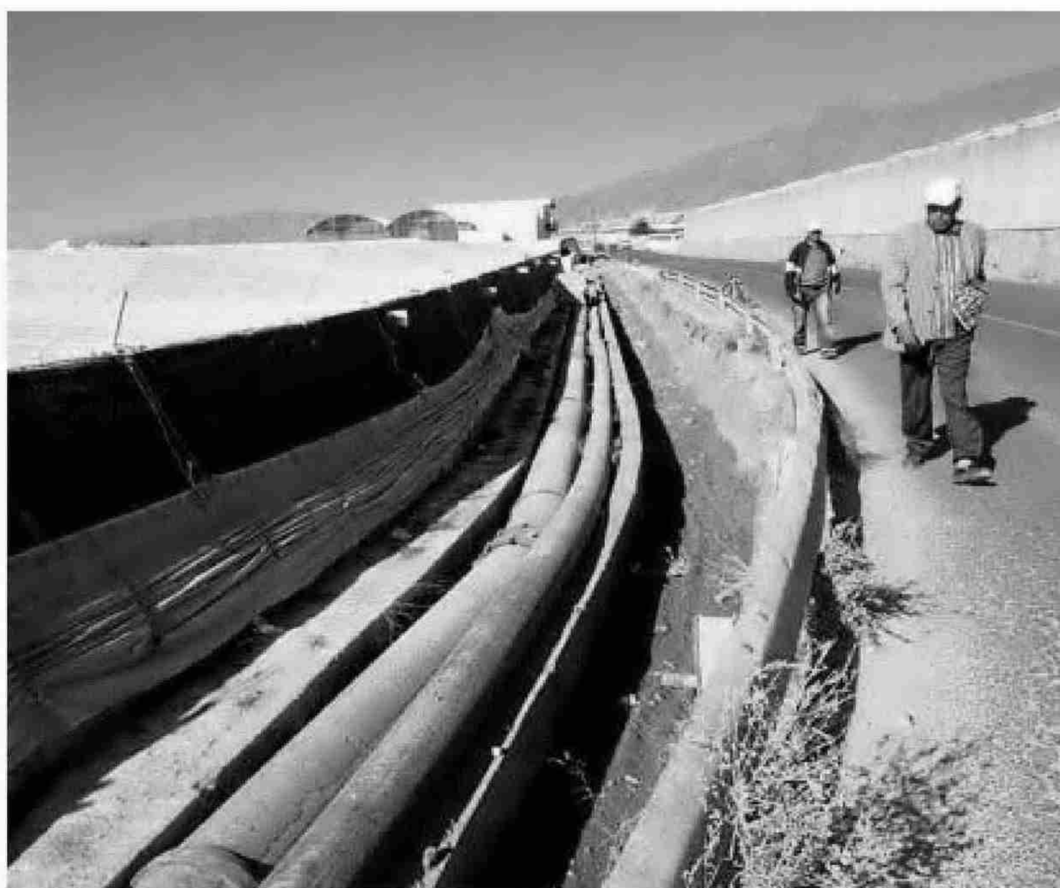
Las obras de mejora de Sol y Arena para duplicar su capacidad de embalse están a punto de culminarse.
