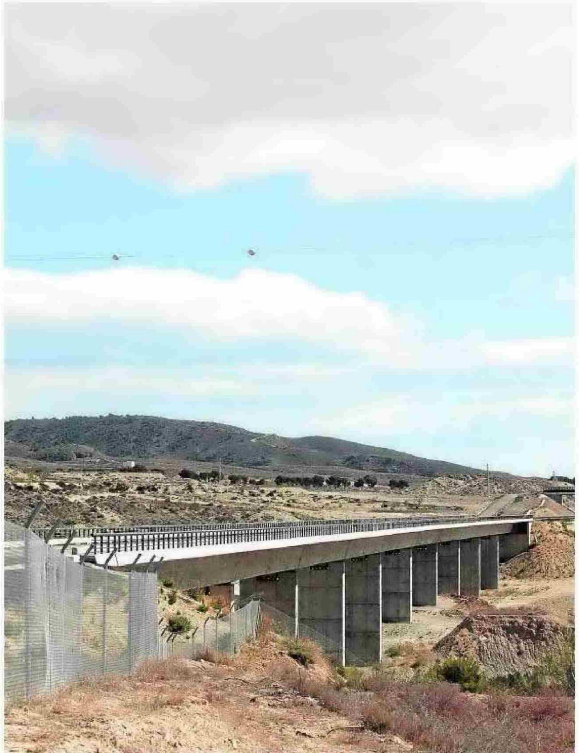
Viaducto ejecutado para el AVE en doble vía en el Levante almeriense. :: M. C.
