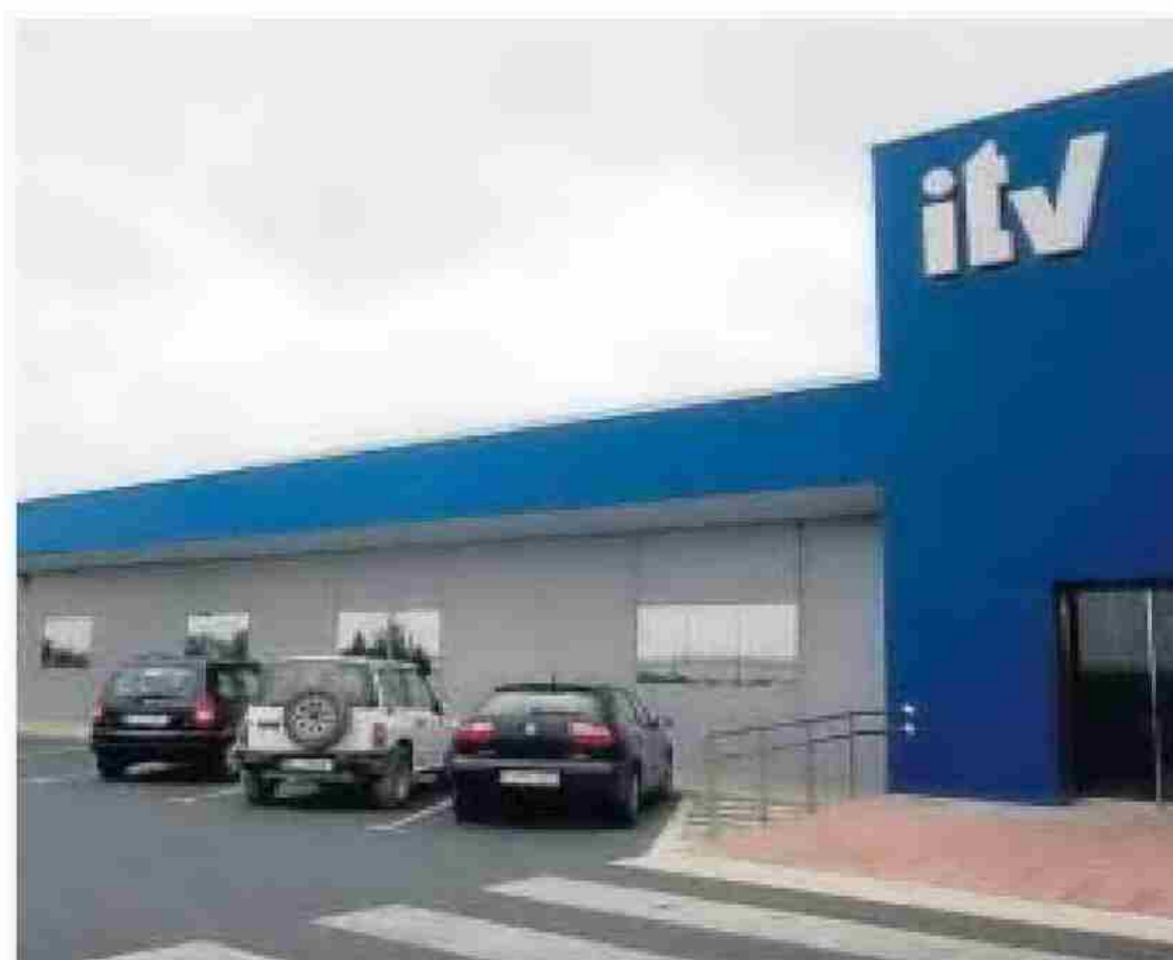
Fachada de las nuevas instalaciones para pasar la ITV.
