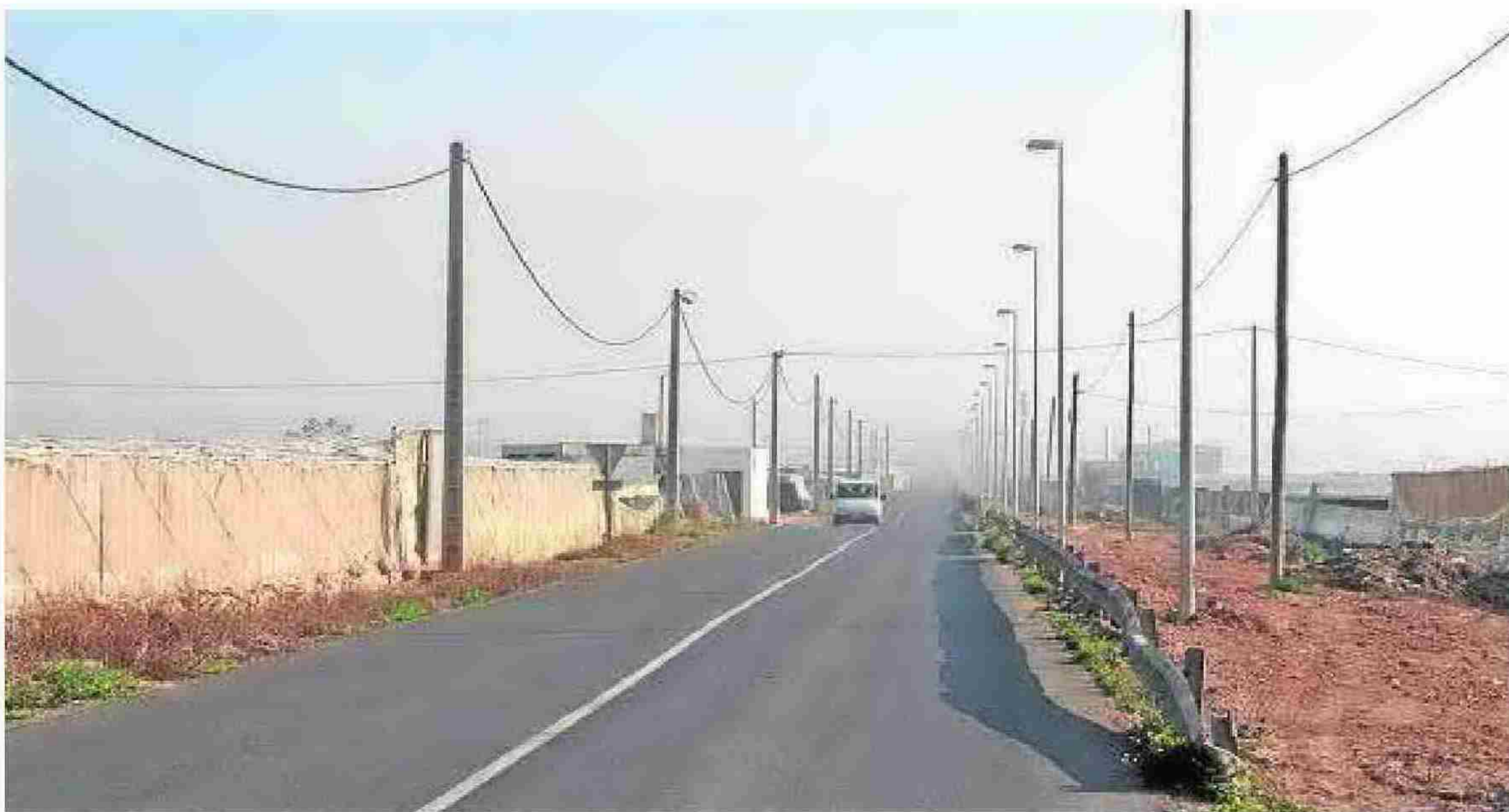
Camino de la Pista, uno de los que serán remodelados dentro de las actuaciones previstas. :: F. G.
