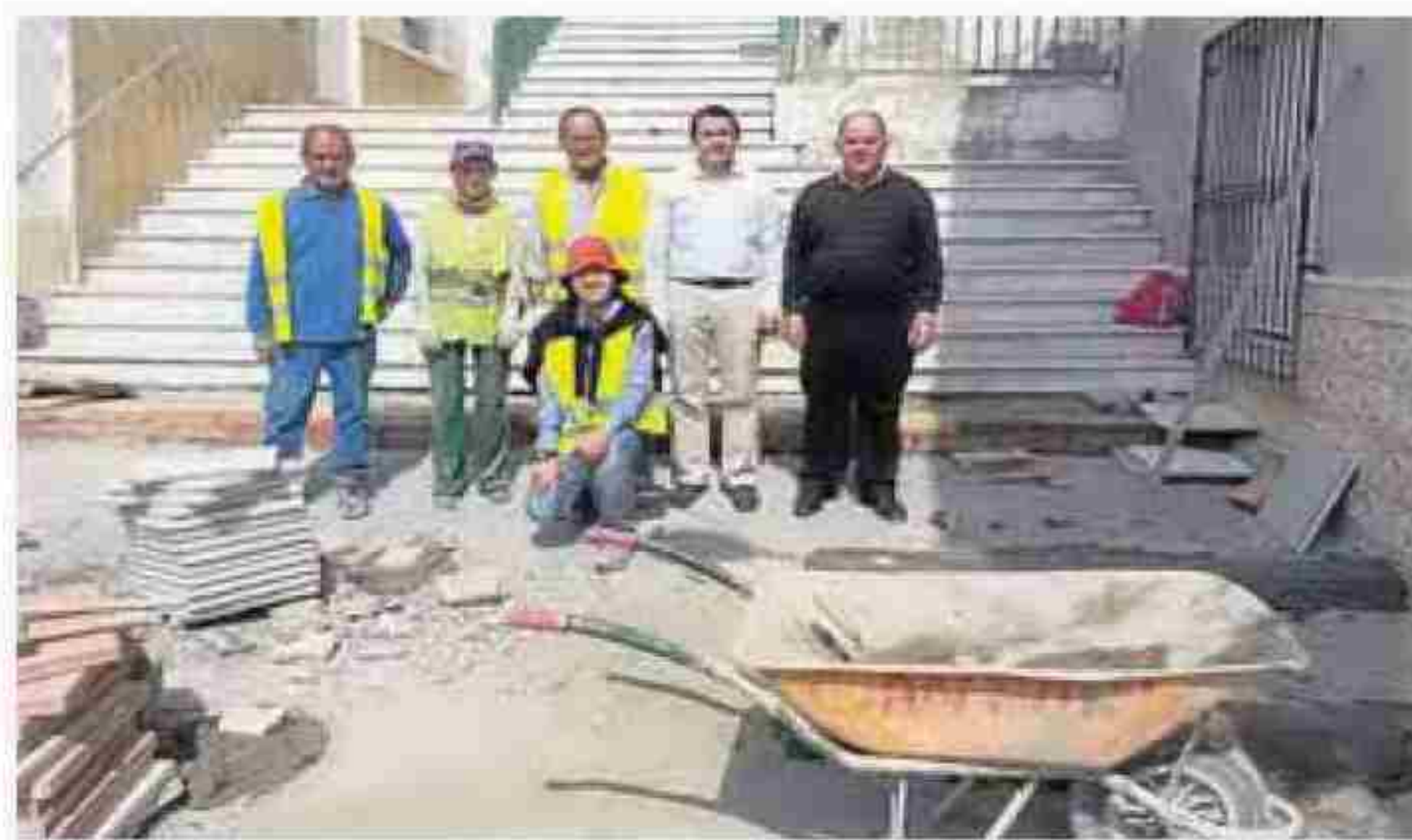
OBRAS del PFEA realizadas en el pueblo de Cantoria. LA VOZ
