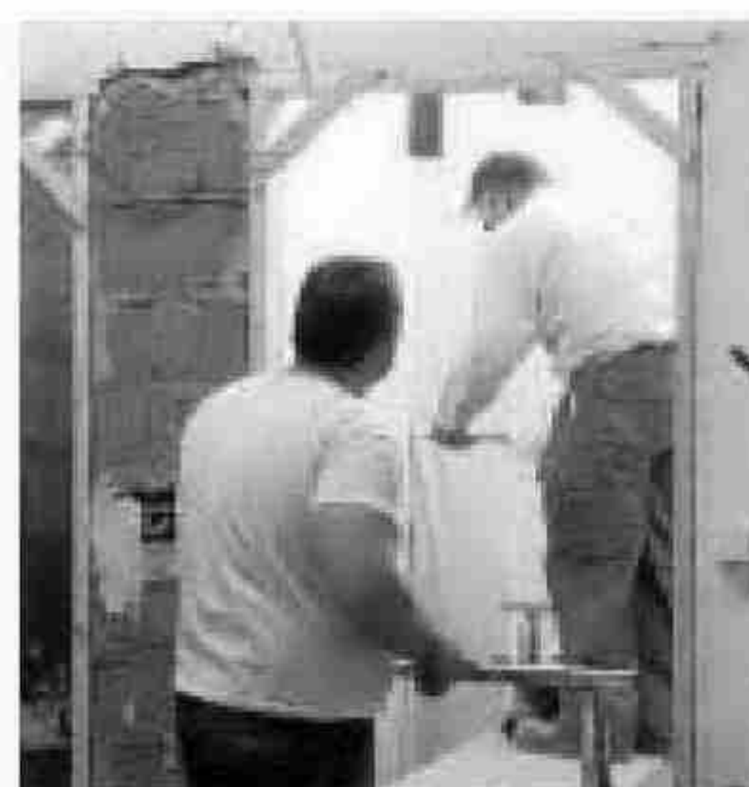
Obras en el edificio.
