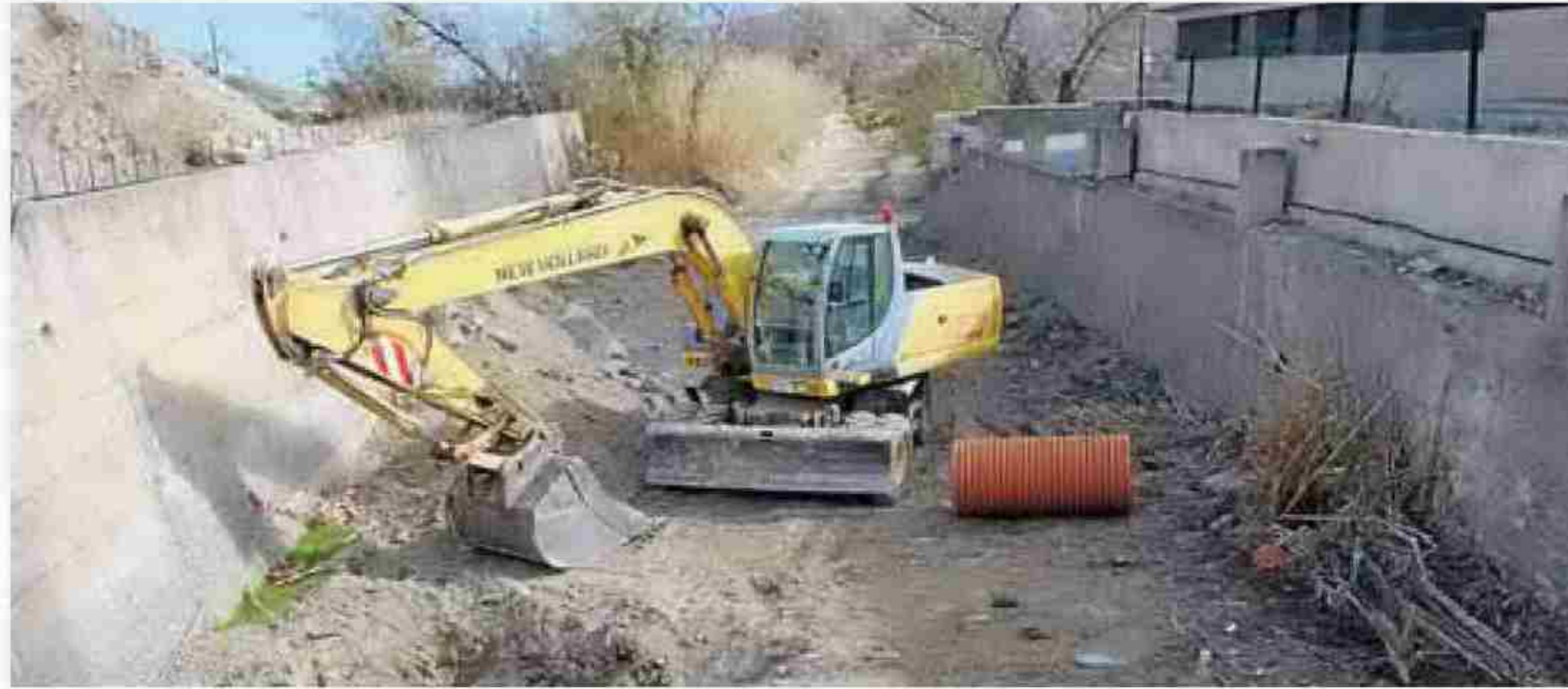
TRABAJOS en la Avenida de la Legión para mejorar el saneamiento del municipio. LA VOZ
