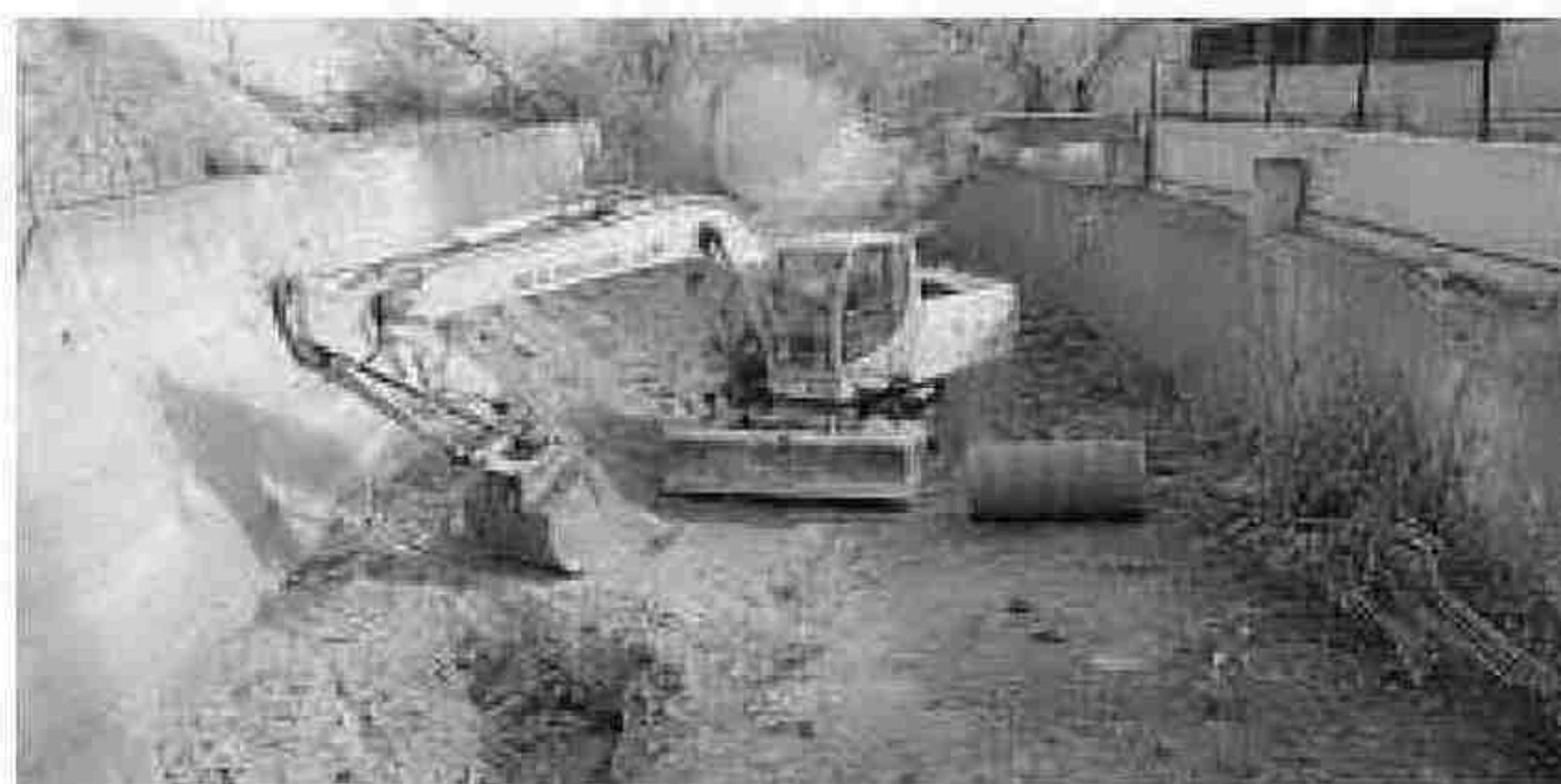
Las obras desaneamiento son las más esperadas.
