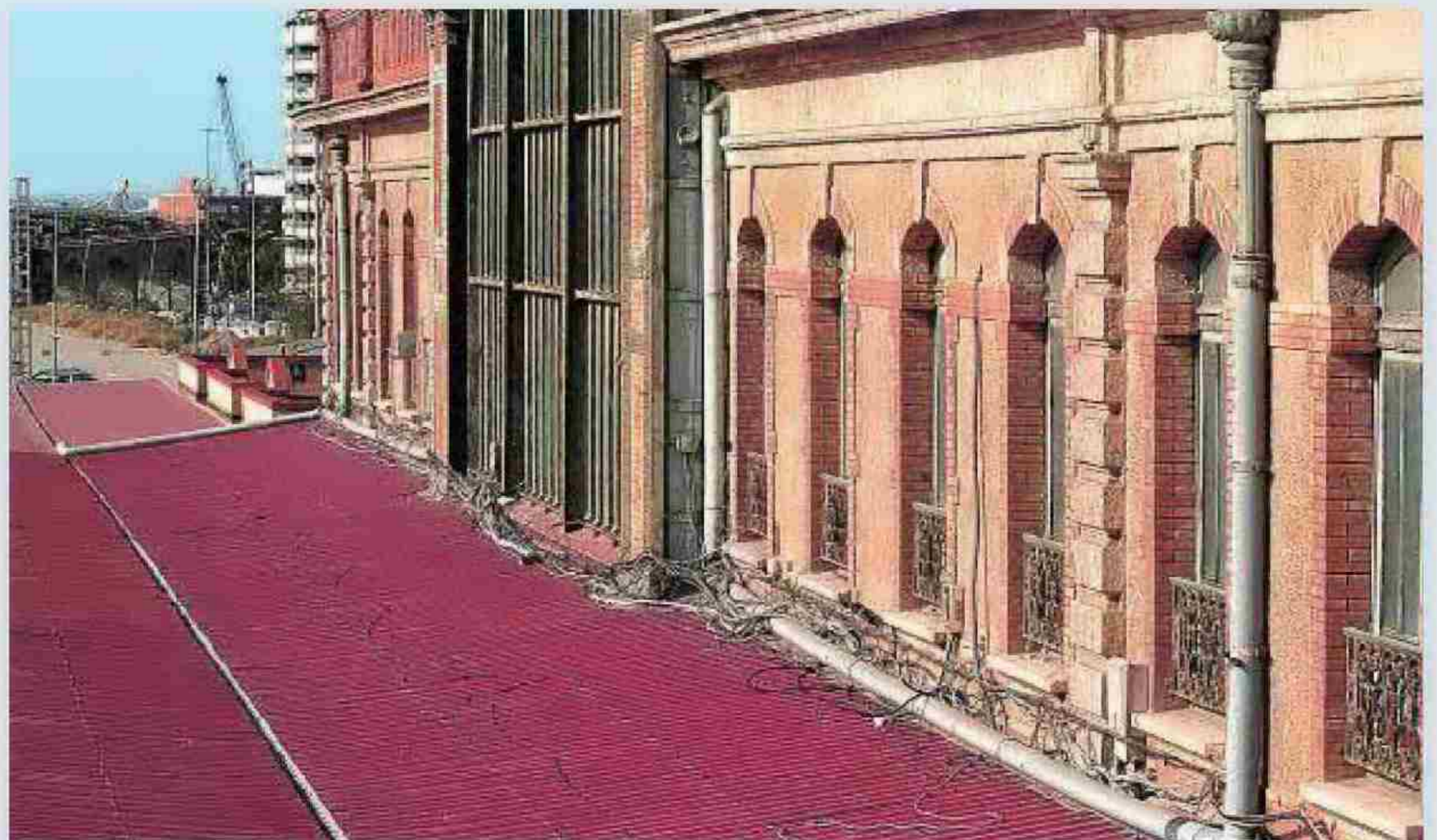
En la cubierta, las madejas de cables y el óxido de las rejas y de la marquesina dan muestra de su estado.
