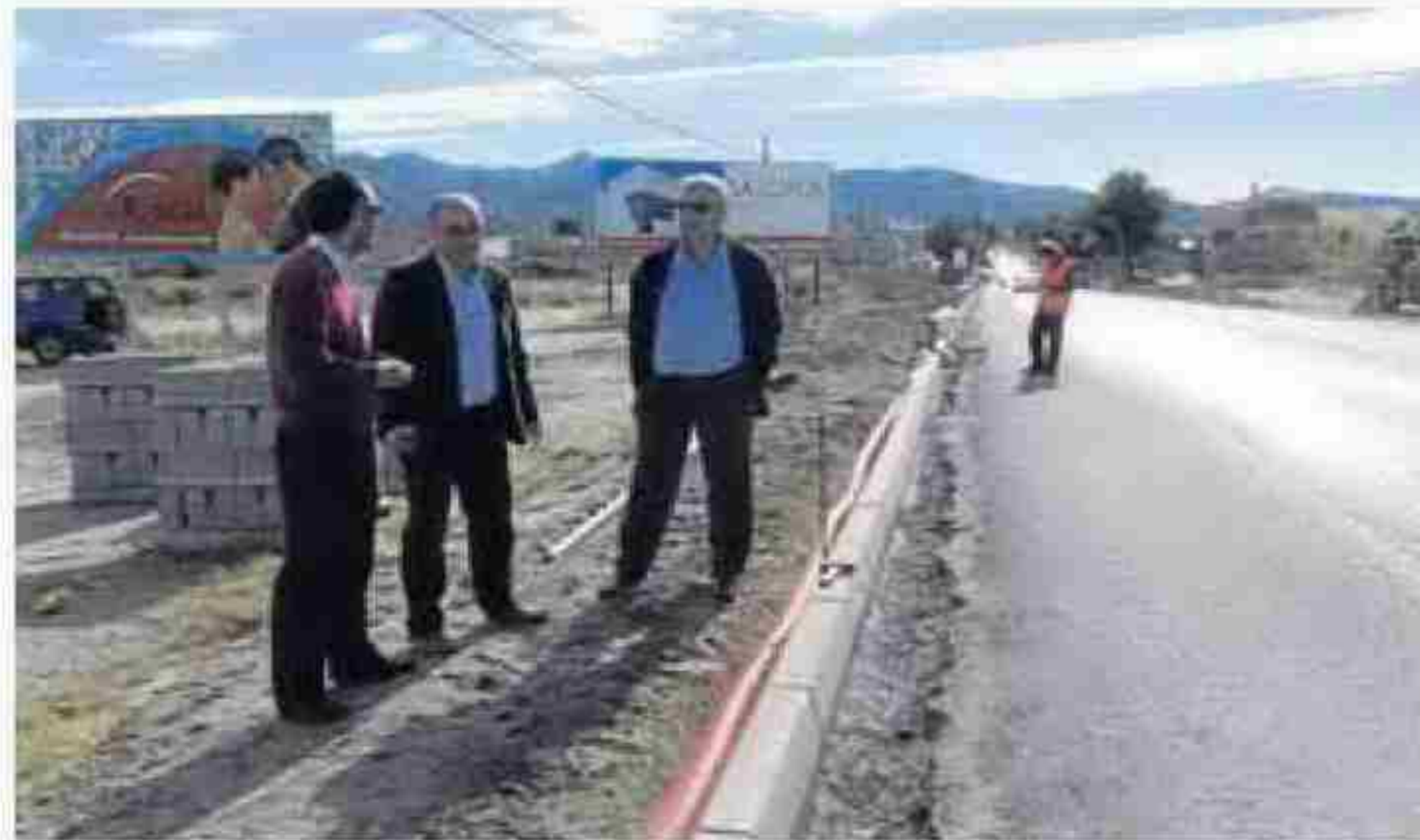
VISITA al lugar de la obra por parte del alcalde. LA VOZ
