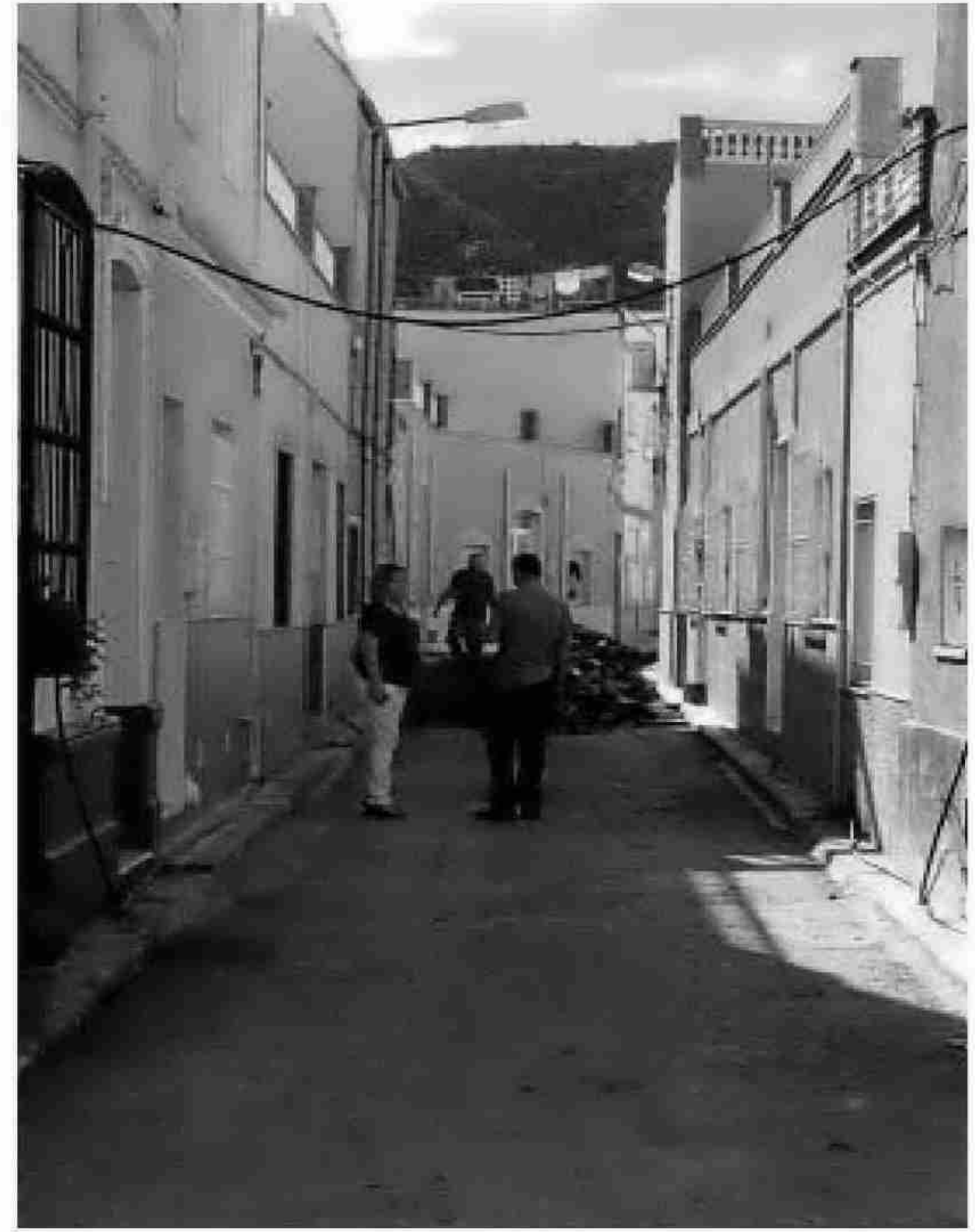
La alcaldesa ha visitado recientemente las obras en la calle Higuera.
