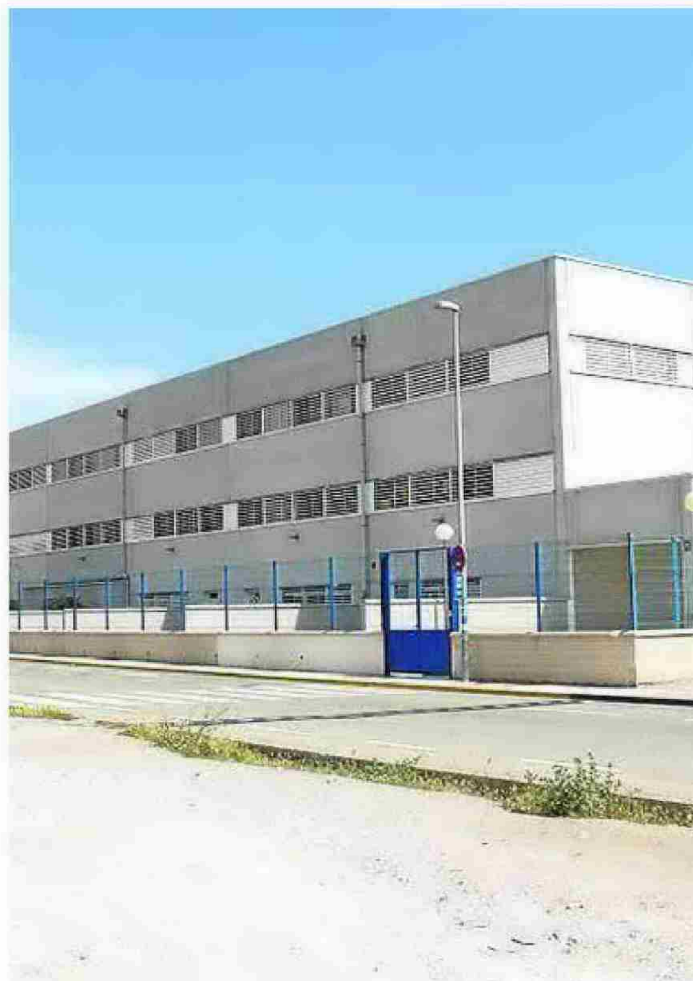
El colegio Torrequebrada es uno de los que tienen problemas. :: IDEAL
