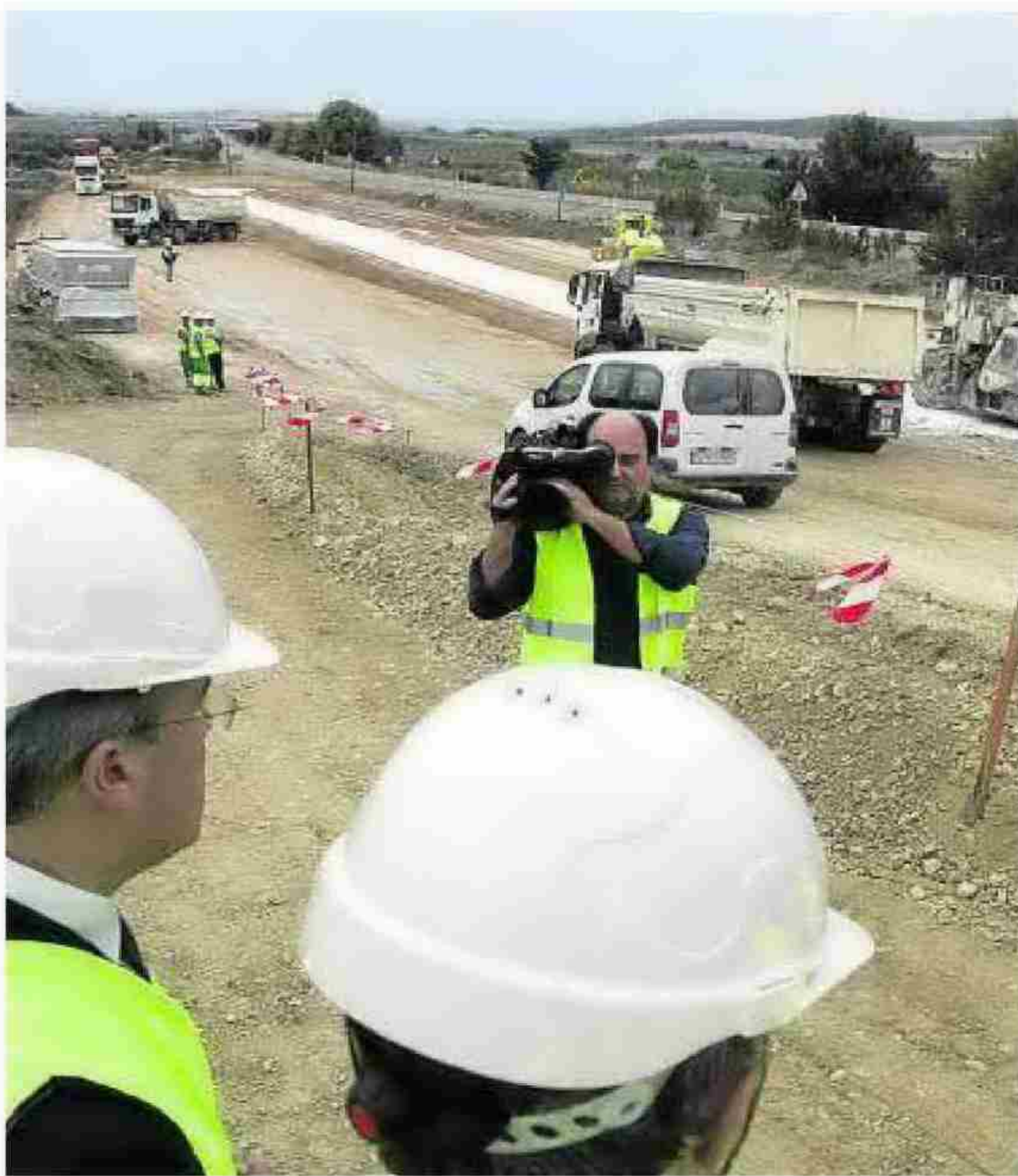
Visita, el miércoles, a las obras del AVE en Jaén. :: FRANCIS J. CANO
