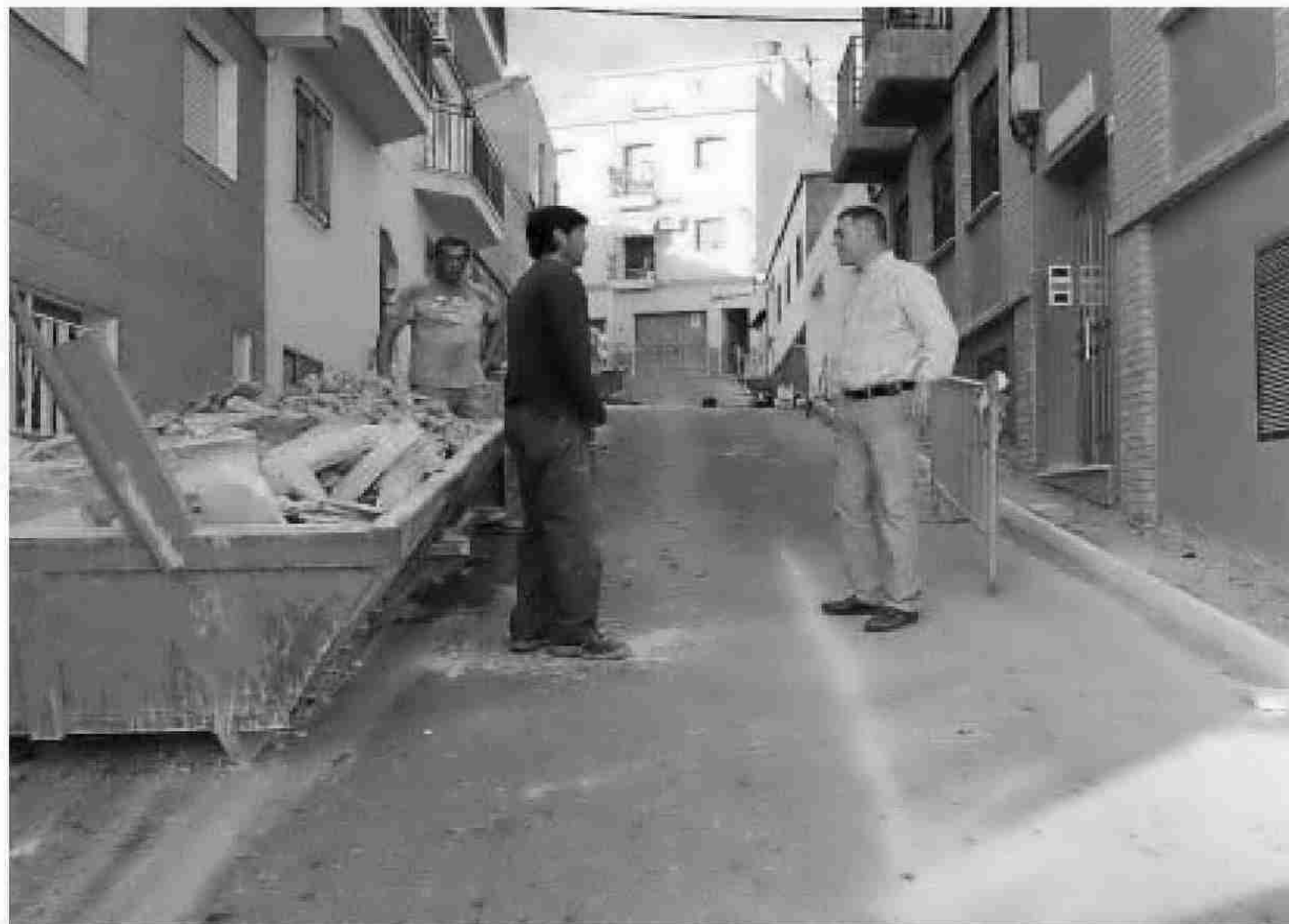
El alcalde ha supervisado los trabajos de acerado que se acometen en la calle Murcia.
