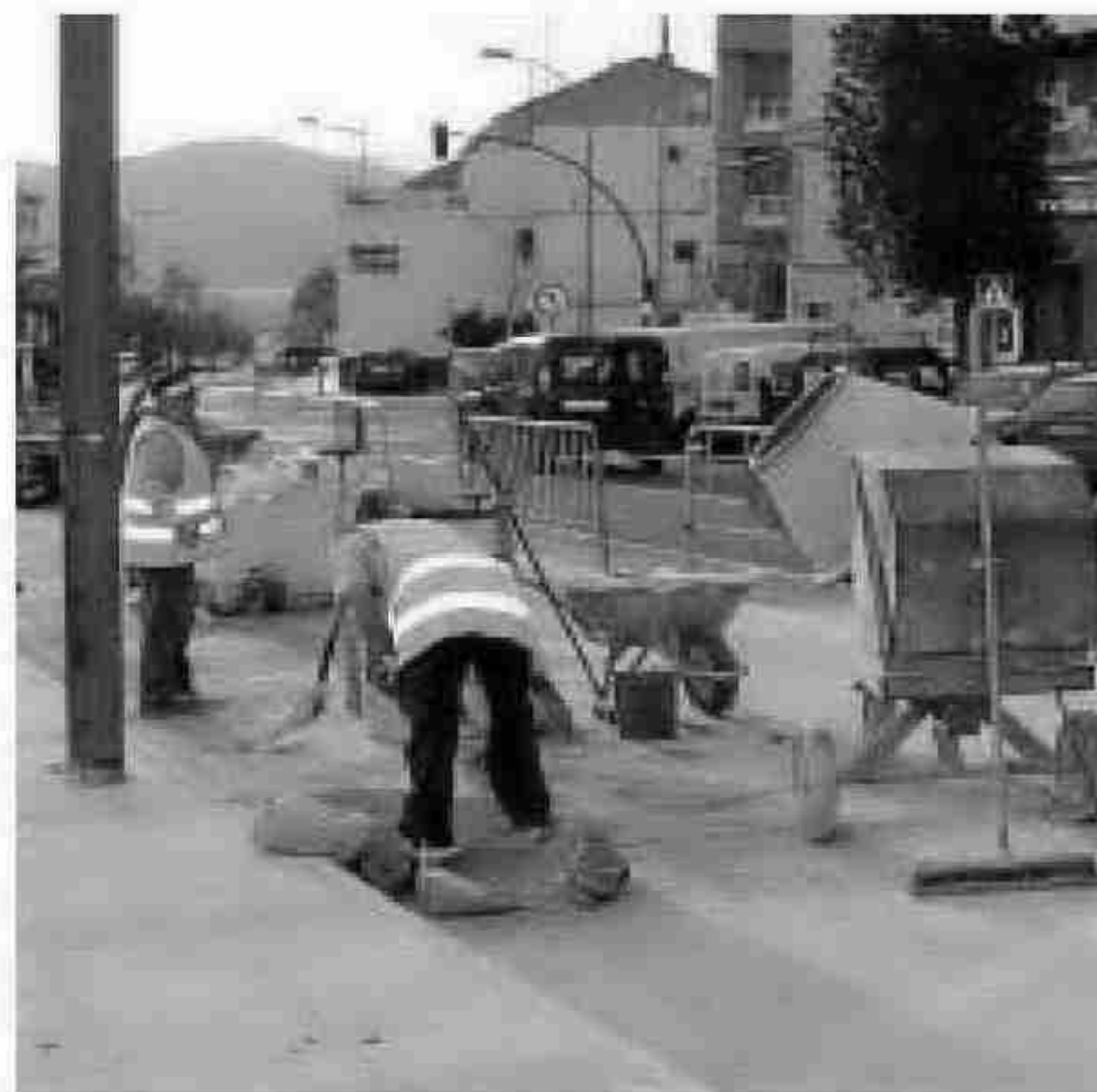
Trabajos de acerado en la Carretera Alta.
