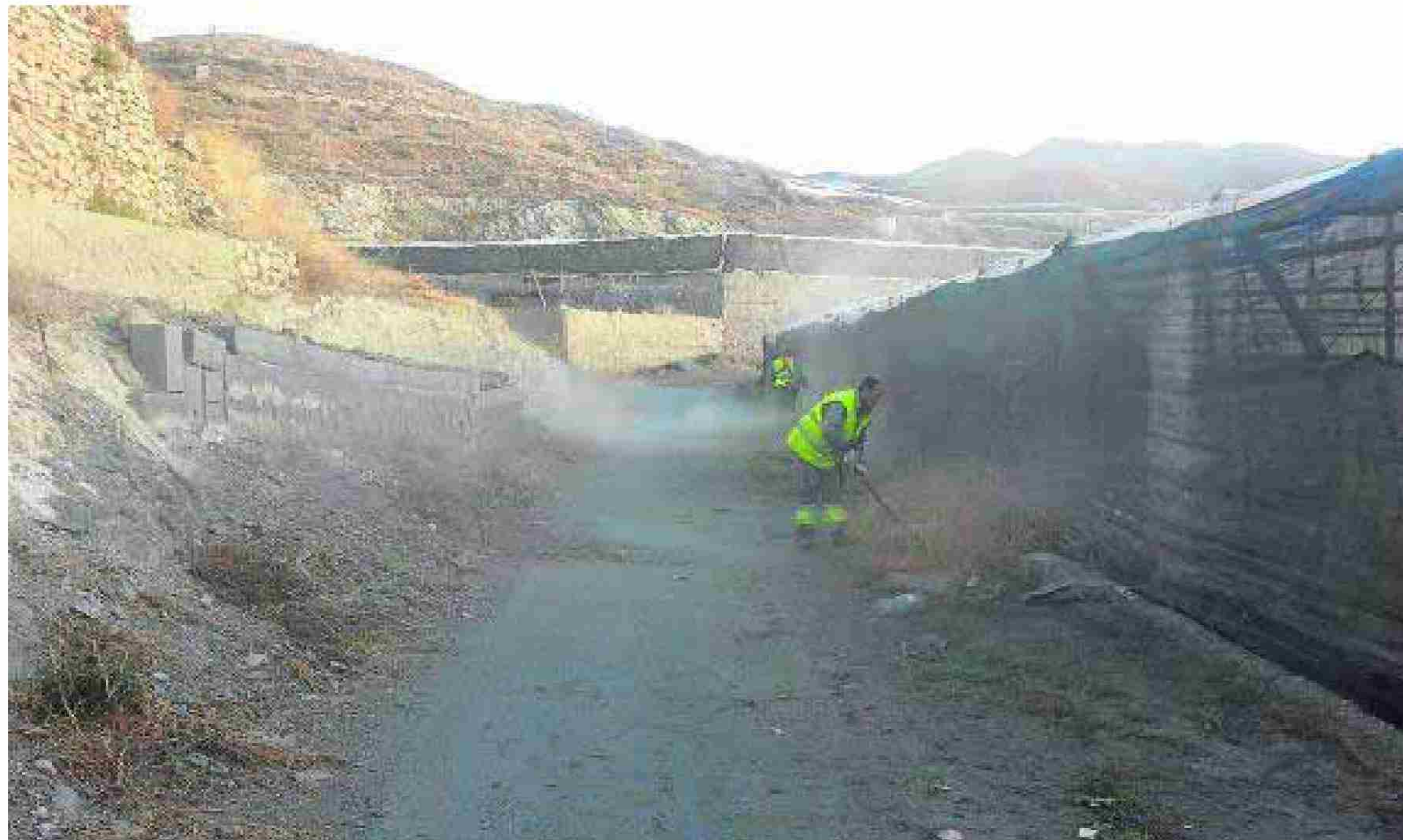
Los primeros trabajos han comenzado en la zona de Poniente, con el camino de Guainos Altos. :: IDEAL
