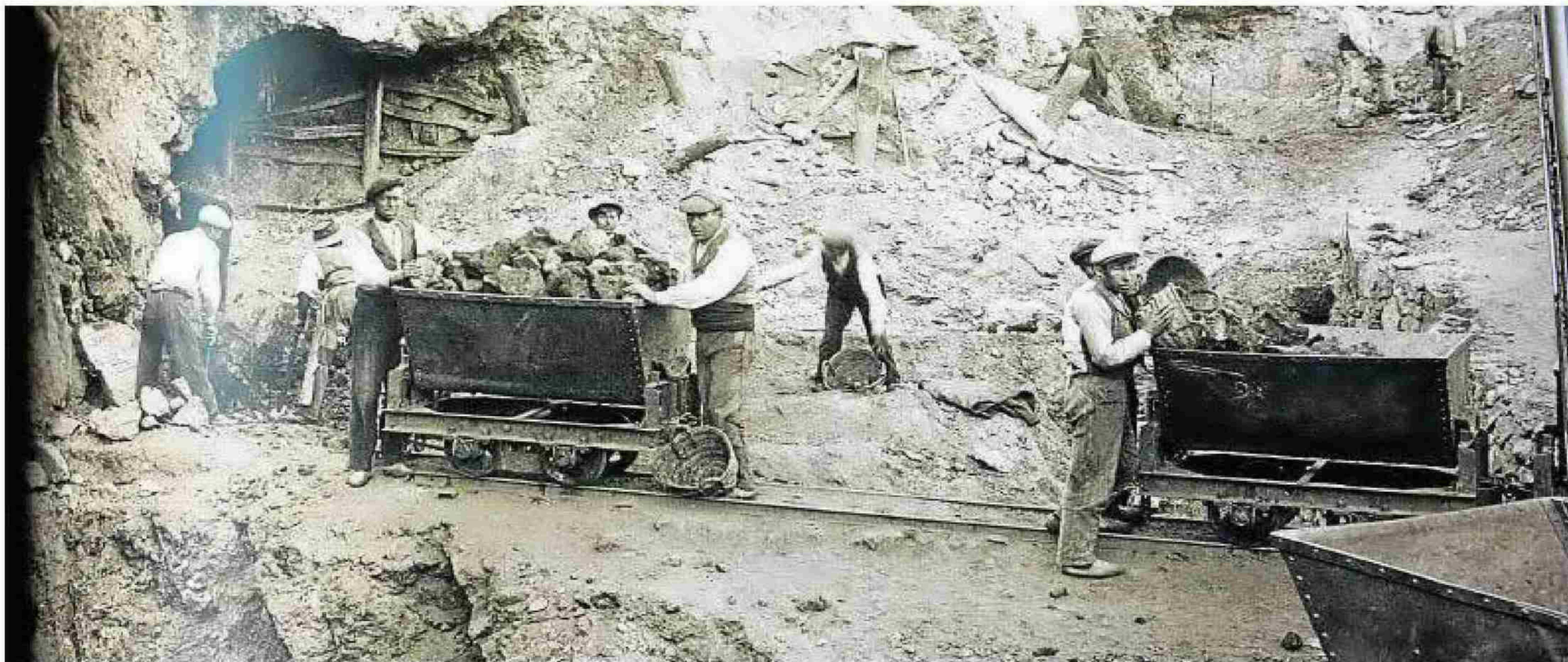
Imagen del libro de Grima donde se observan obreros trabajando en distintas tareas, cargando el mineral en vagones con espuestas de esparto. :: E. BENÍTEZ
