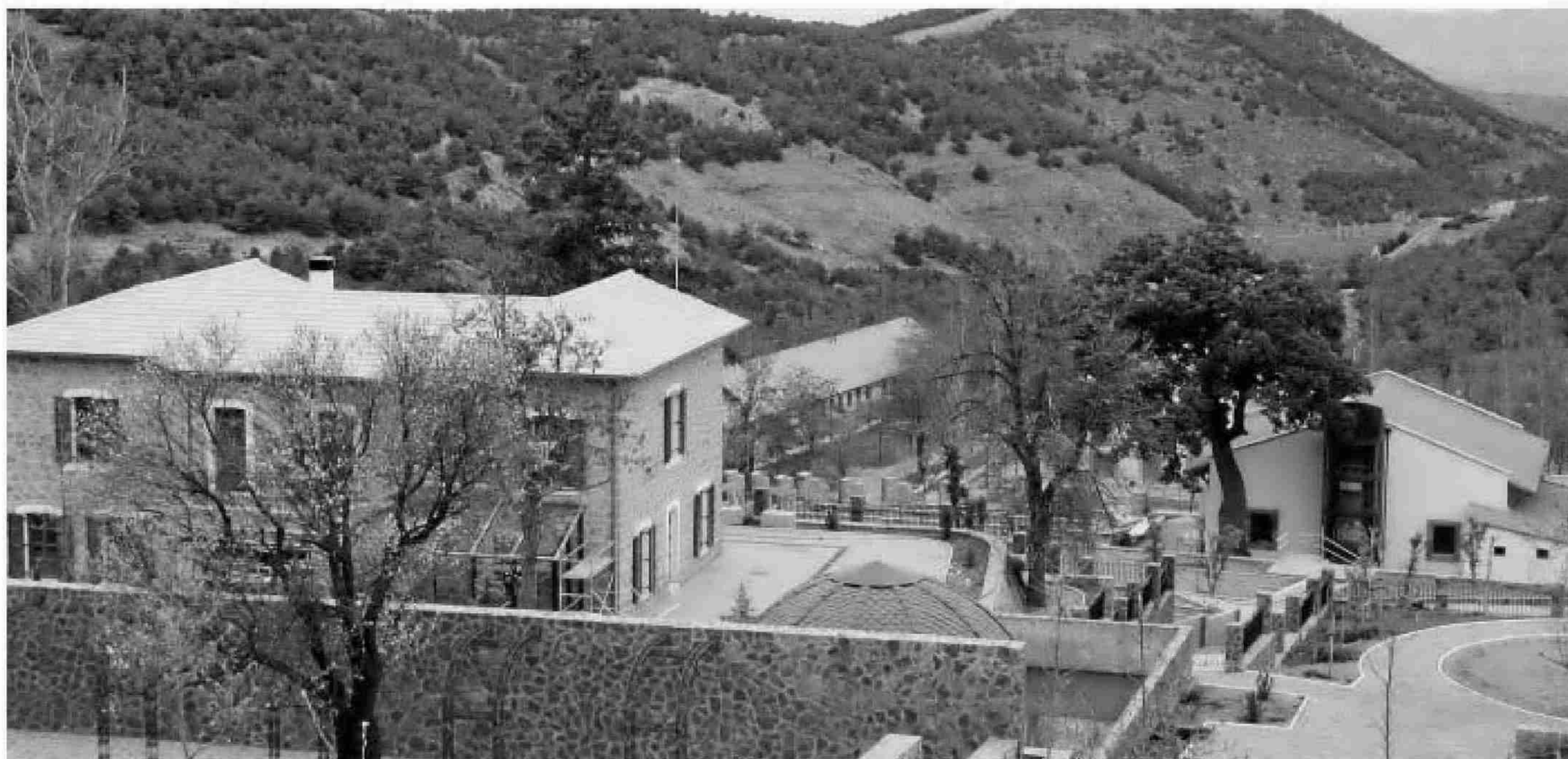
Poblado minero de Las Menas, donde se han restaurado algunas de las viviendas e instalaciones que utilizaban los mineros en el siglo XX.
