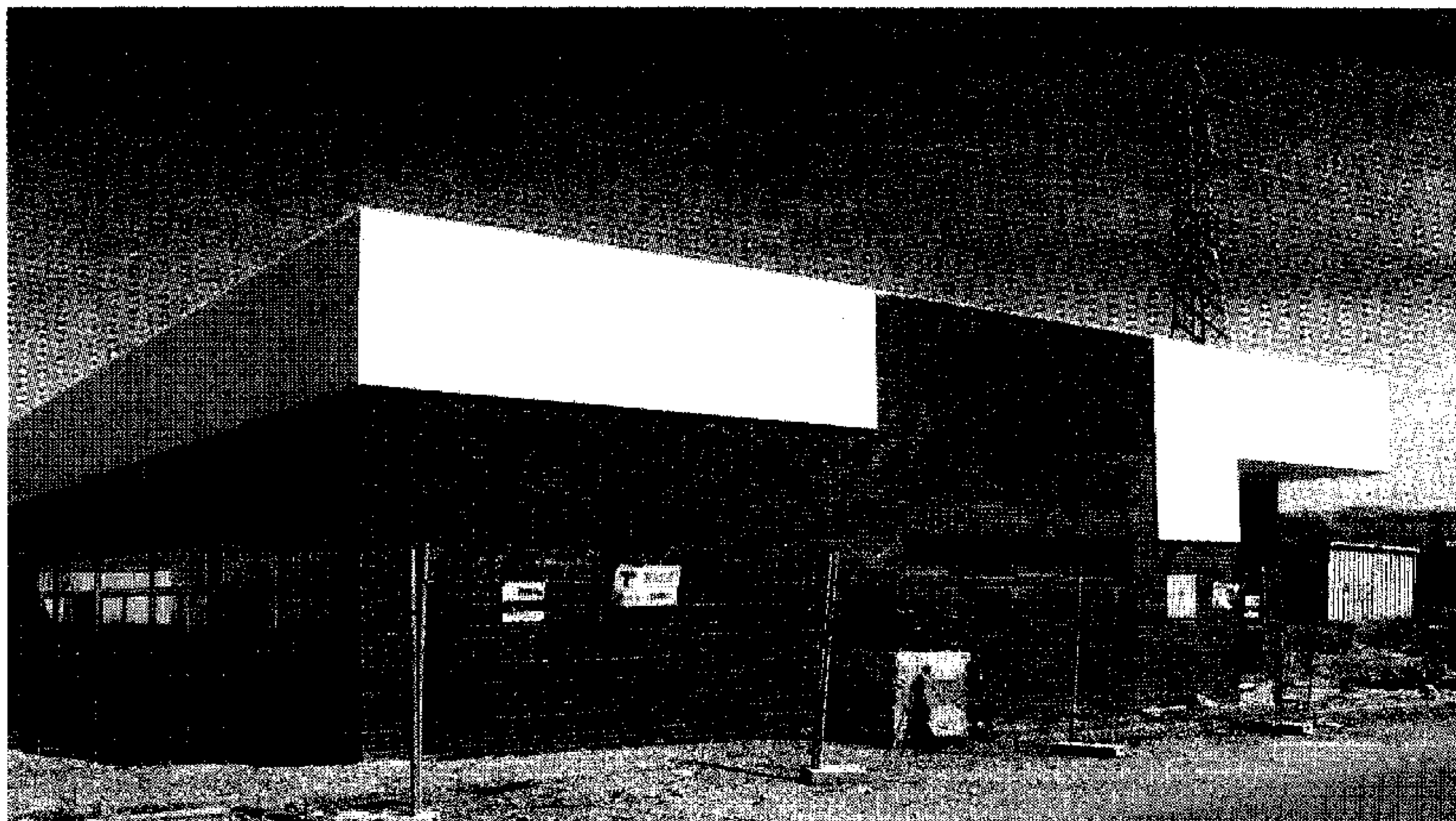
Aspecto que presentan actualmente las obras del nuevo centro de salud de Venta del Viso. :: F. GRANADOS
