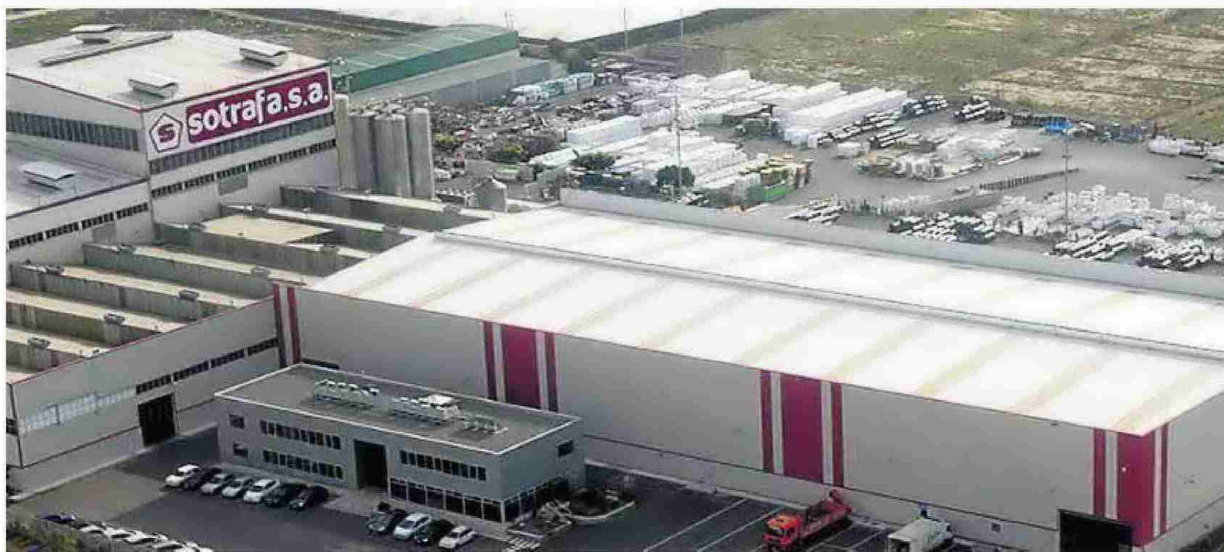
Instalaciones en las que Sotrafa fabrica Plásticos en el Poniente almeriense. de IDEAL
