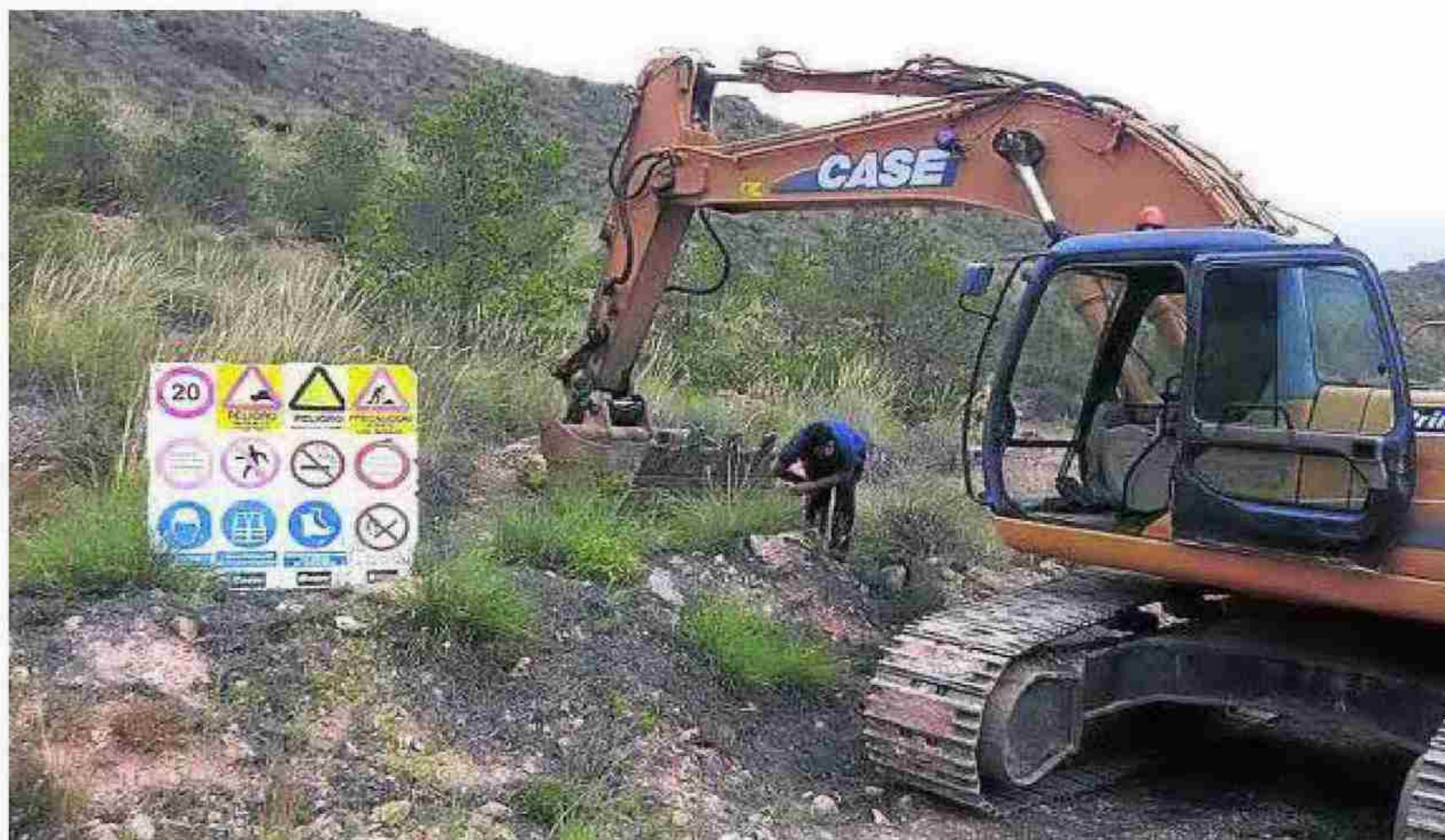
Obras para reparar las tuberías del trasvase del Negartín-Almanzora, en Cuevas del Almanzora. :: IDEAL
