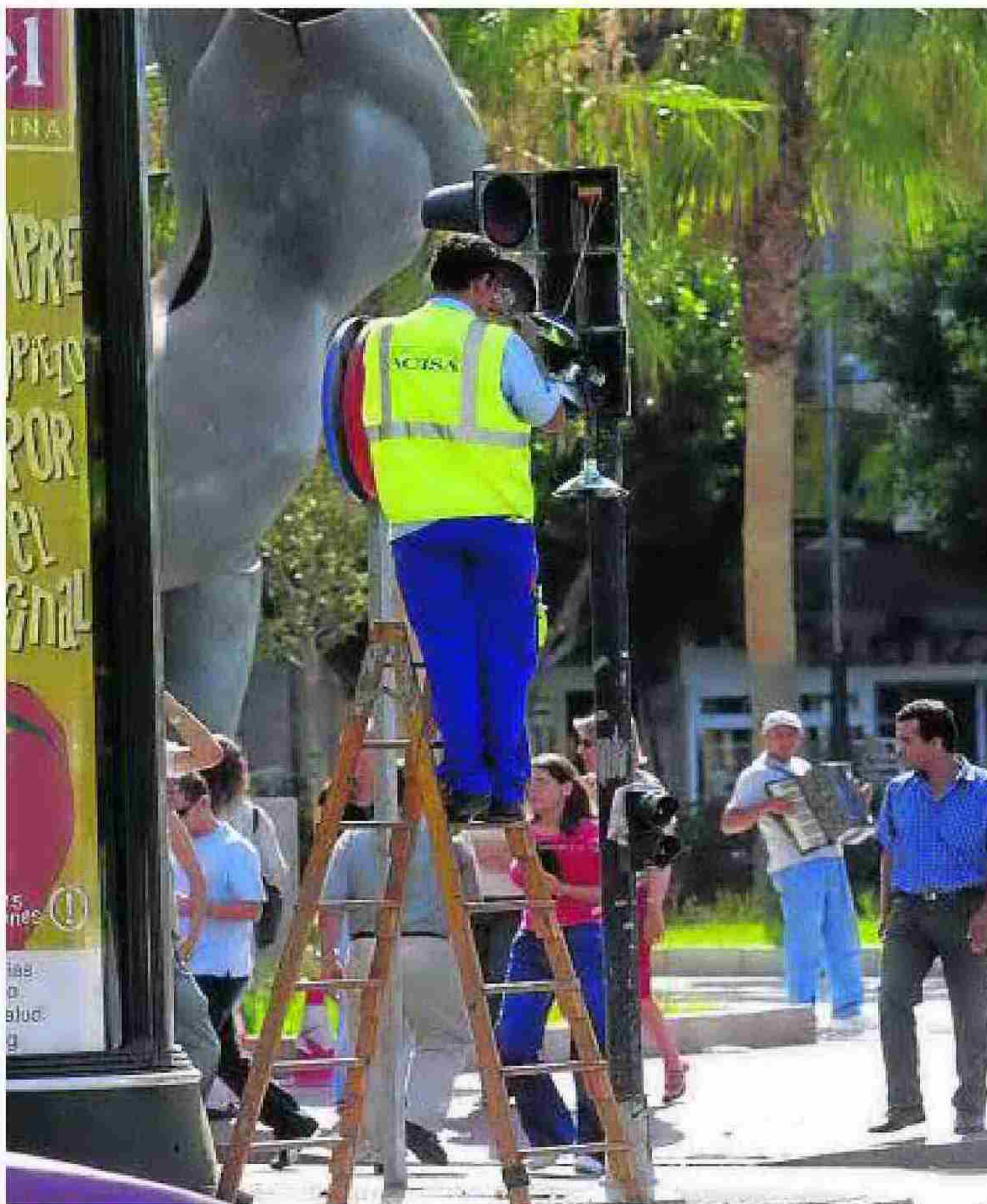
Un operario de mantenimiento trabaja en un semáforo. :: IDEAL
