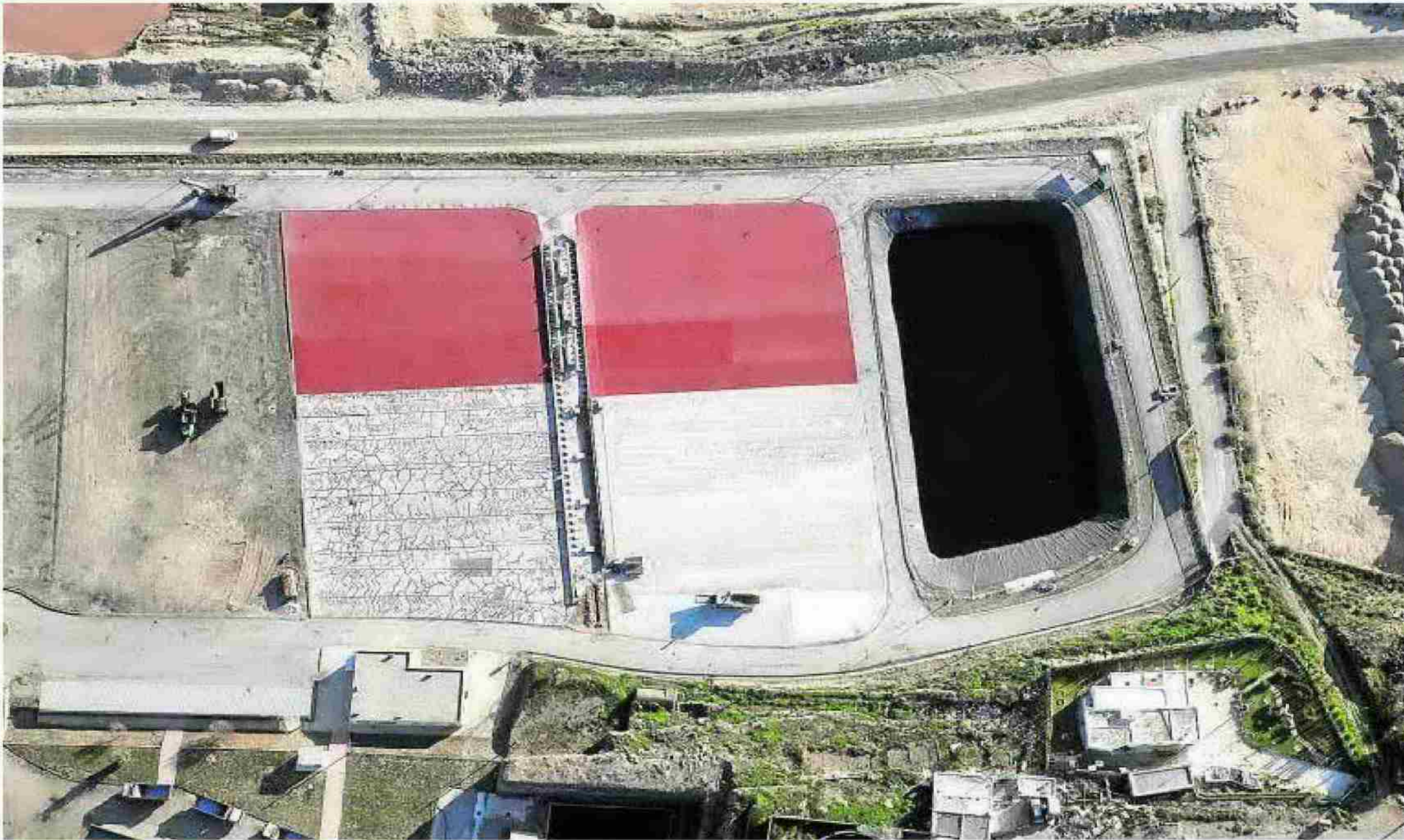
Instalaciones de la planta de gestión de restos vegetales de Albaida, después del incendio del pasado mes de agosto. :: IDEAL
