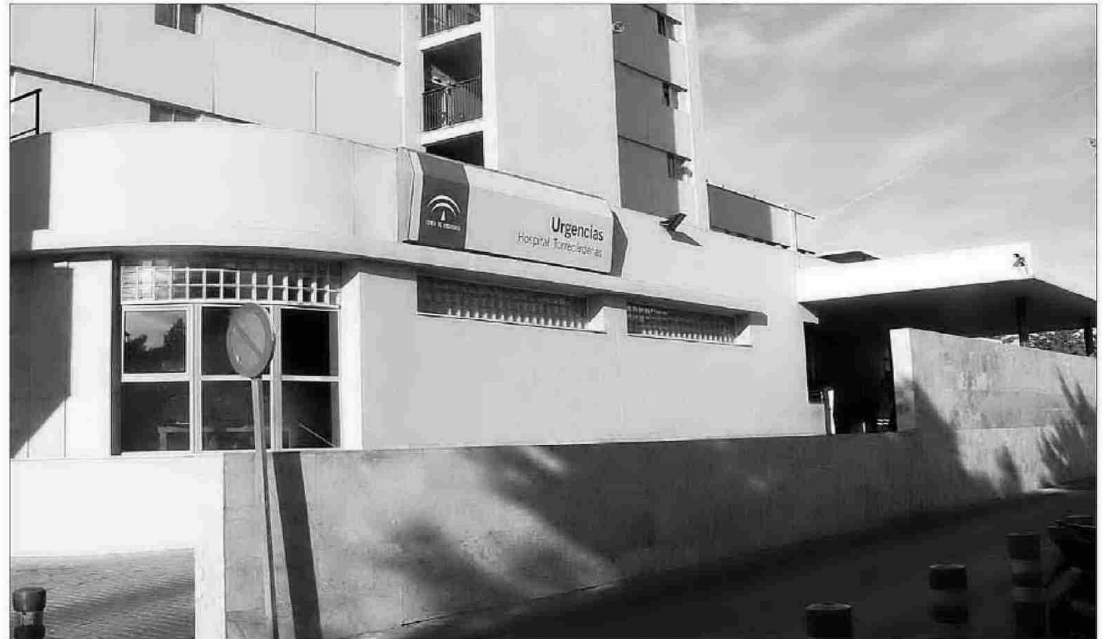
■ Acceso directo al área de Urgencias en el hospital Torrecárdenas. / LA VOZ
