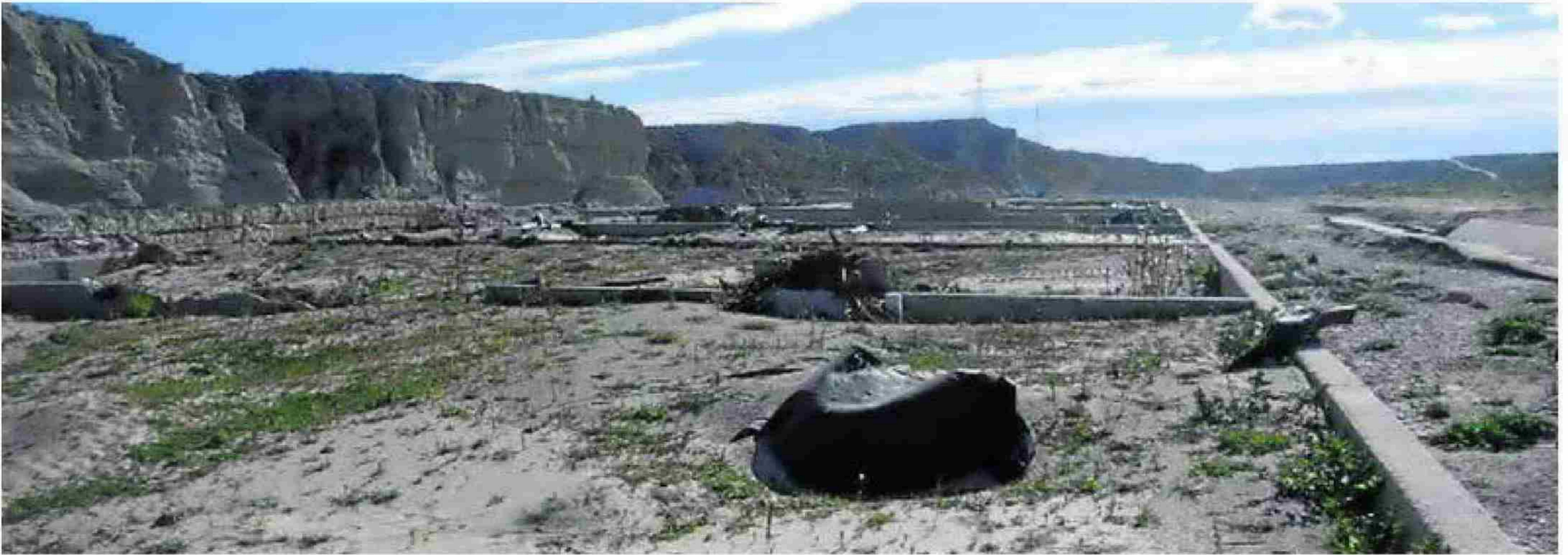
Lo que quedó tras las lluvias de septiembre y queda en el cauce del río de la antigua depuradora de aguas residuales de Antas. :: J. S.
