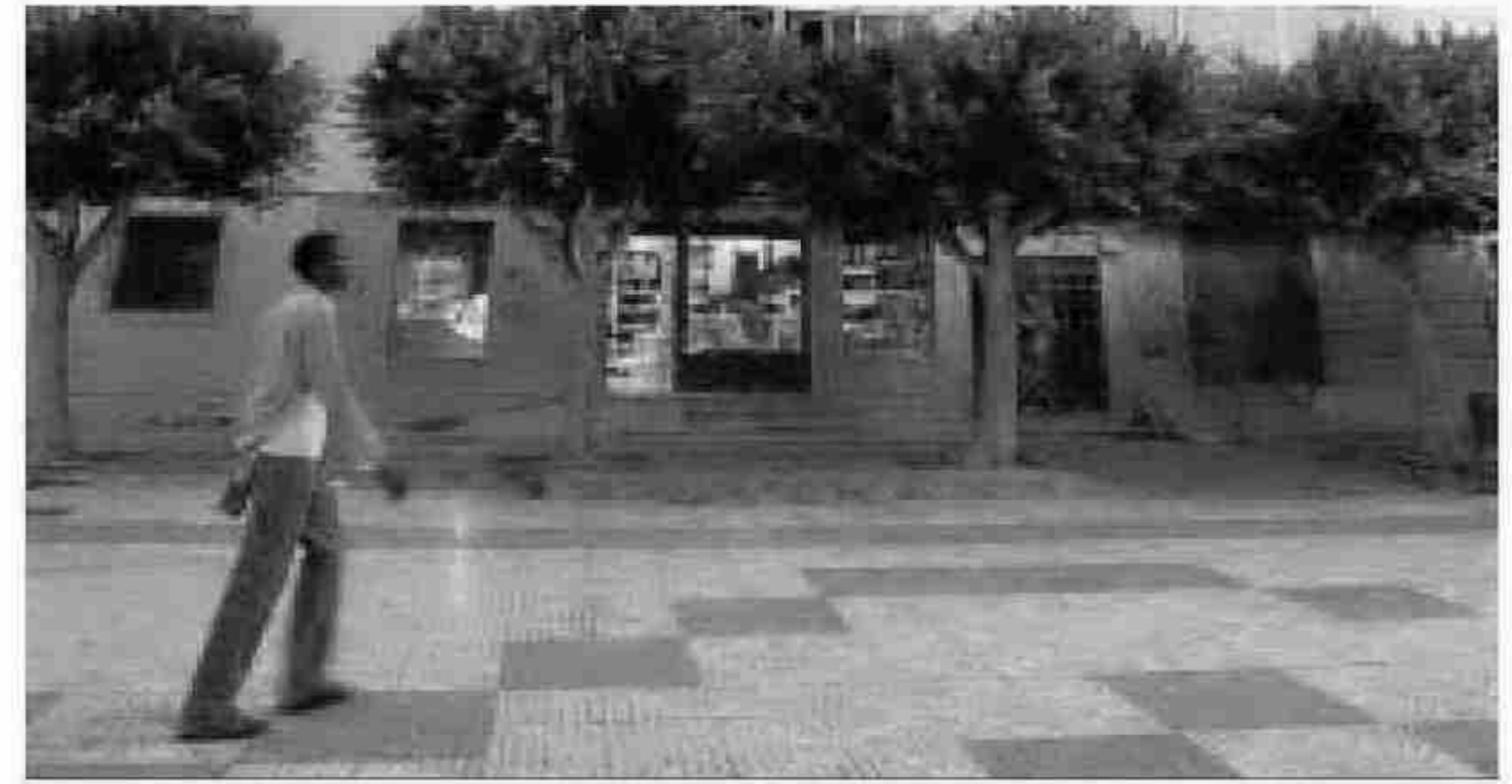
La rehabilitación de las 200 viviendas se debatirá en el Pleno.
