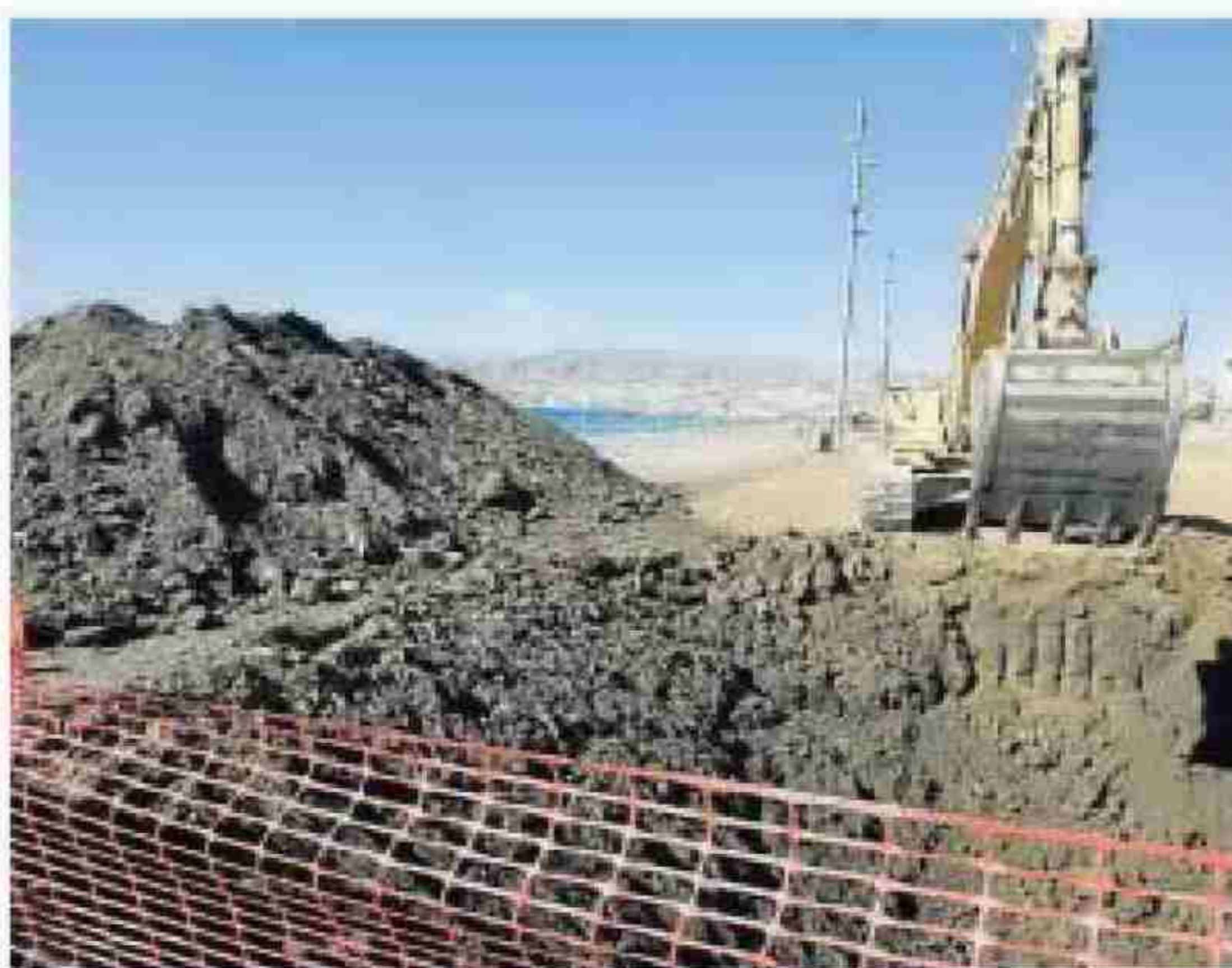
Estado actual en el que se encuentran las obras del Paseo Marítimo.
