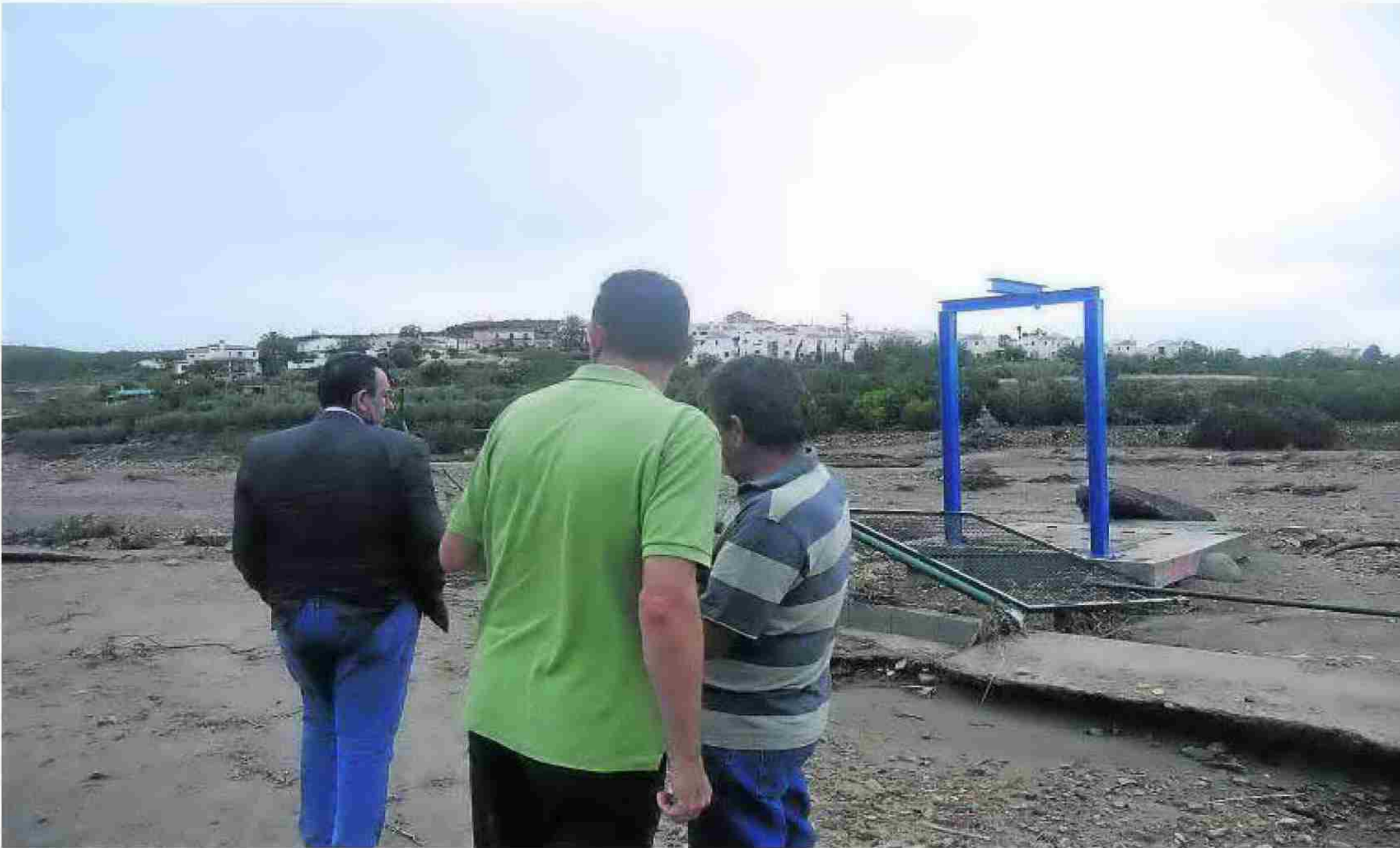
El día después de las riadas comprobando lo que quedó de otra depuradora, la de Alfaix en Los Gallardos. :: J.S.
