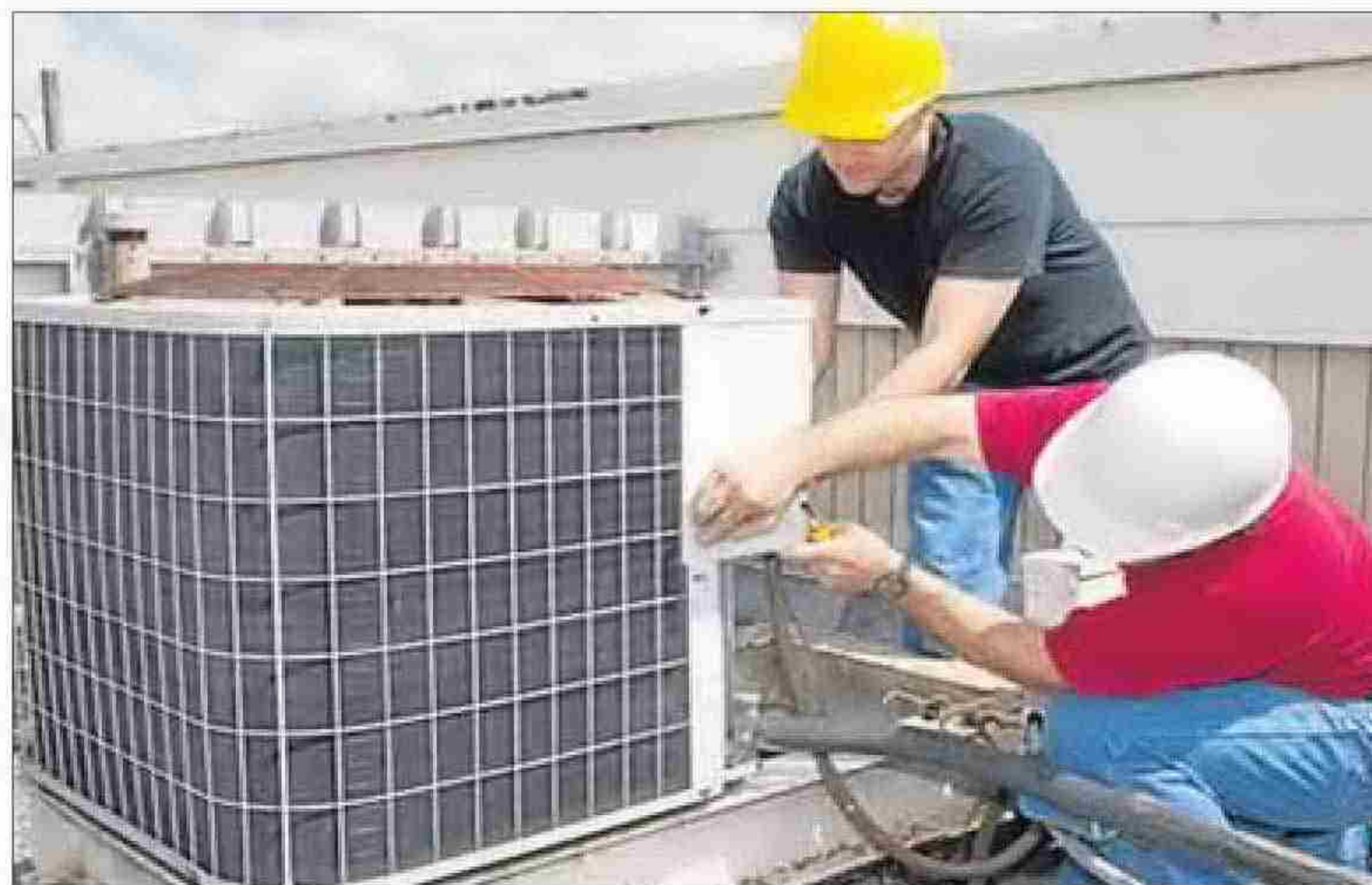
■ Operarios cambiando un aparato de climatización. / LA VOZ
