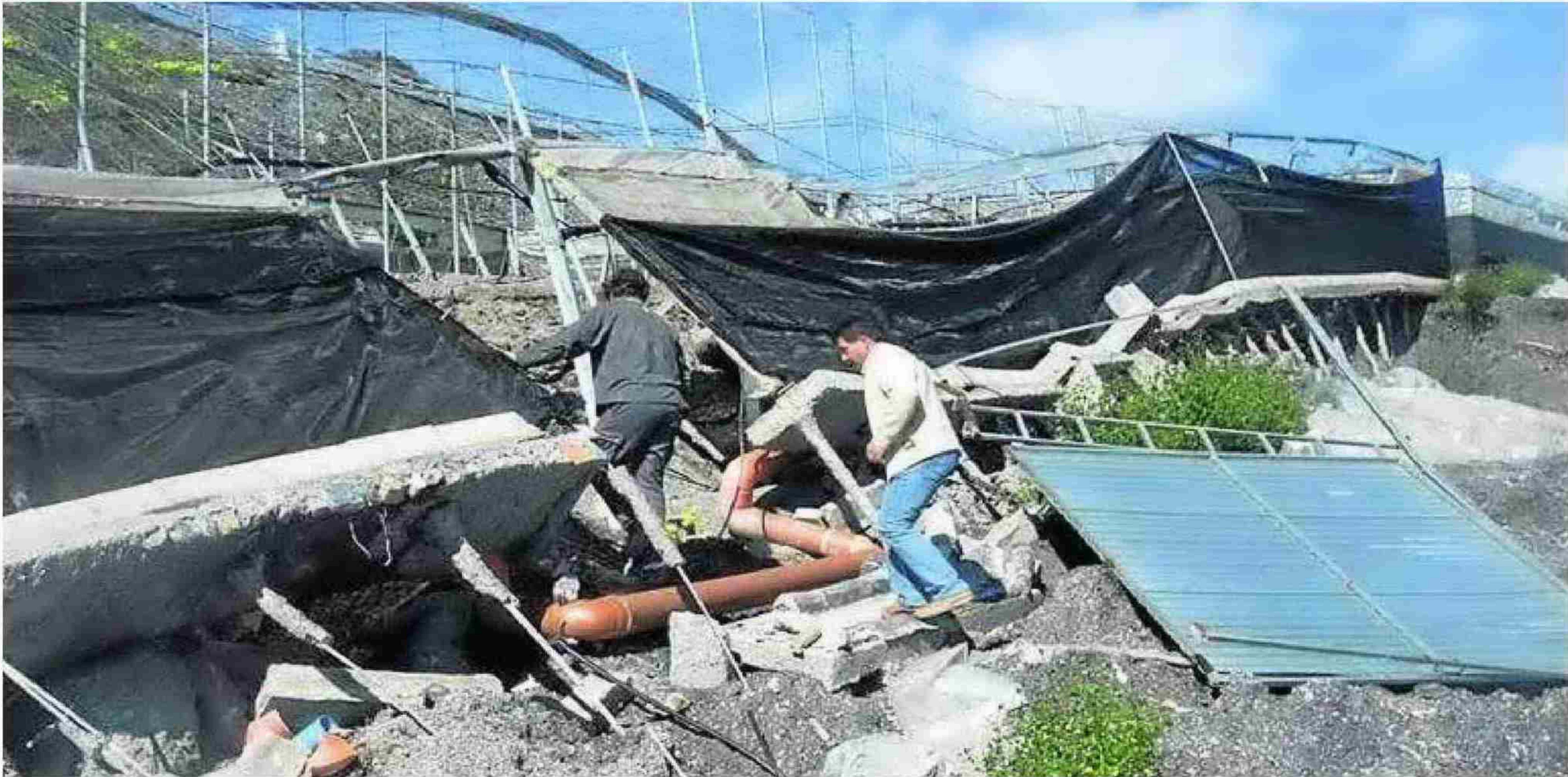
Invernadero que presenta deterioros producidos por el viento. :: IDEAL
