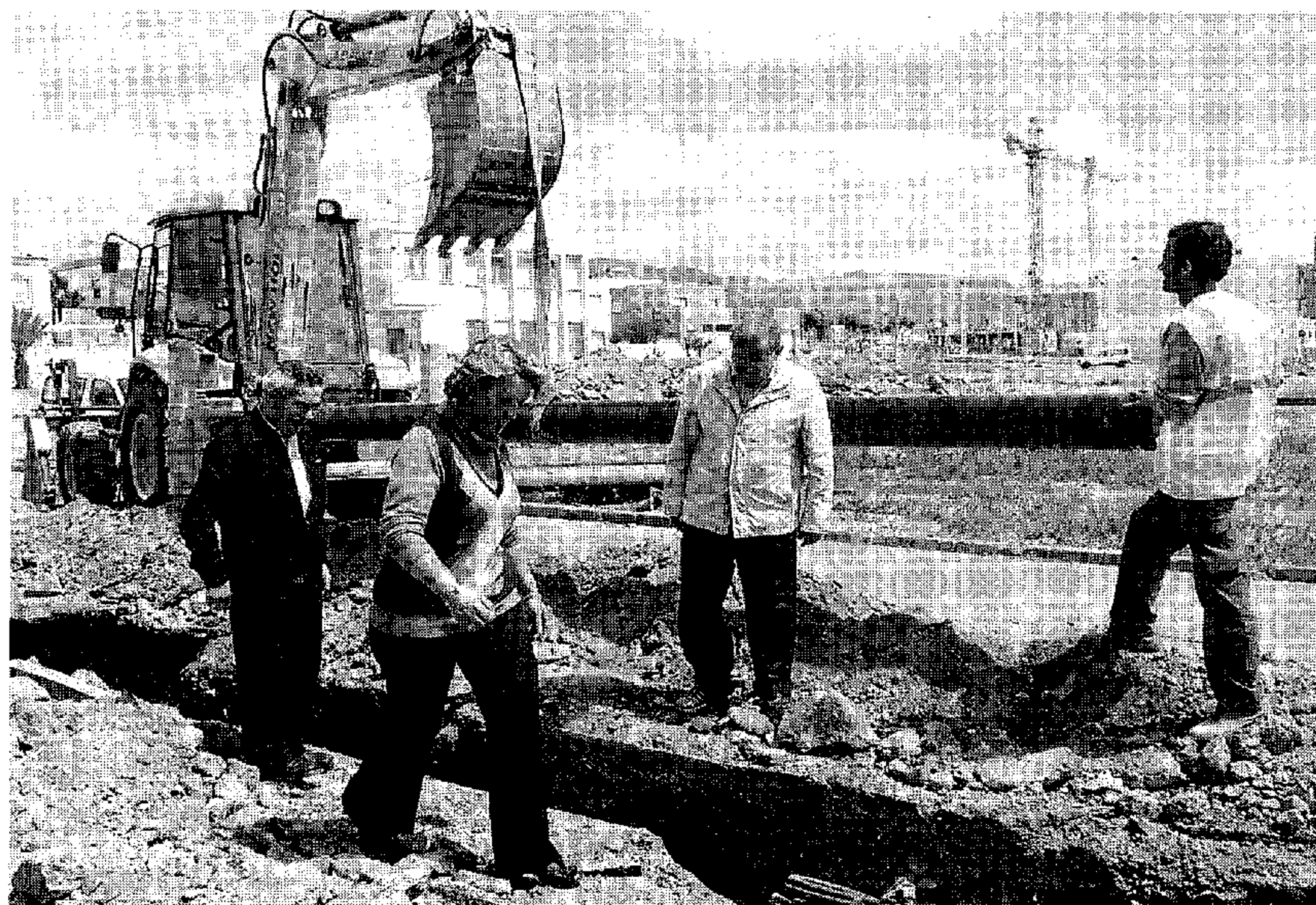
Obras de mejora de alumbrado en Vívar realizadas hace dos años a través de Planes Provinciales.
