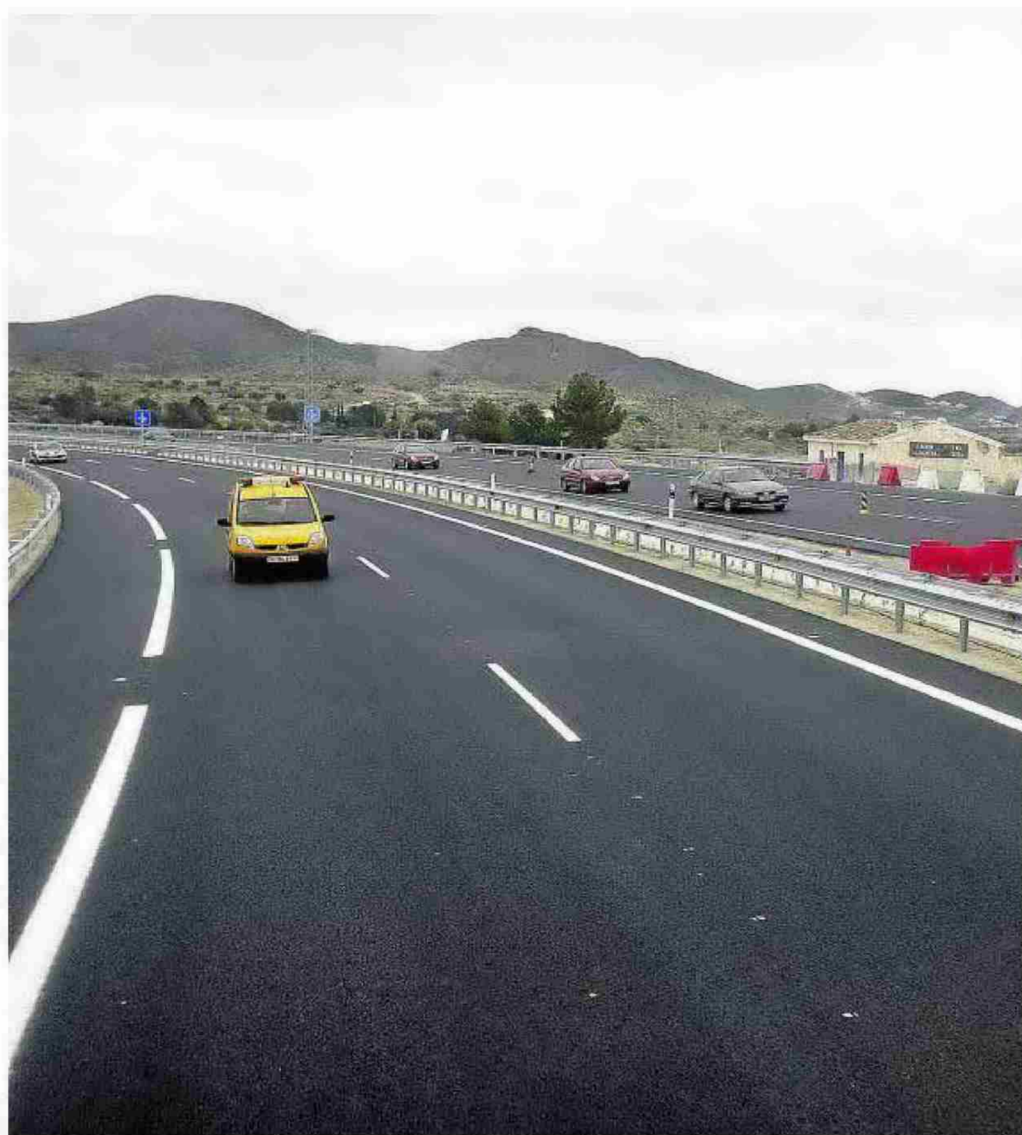
Obras en la Autovía del Almanzora, una de las principales obras en la cartera de la Junta. :: EFE
