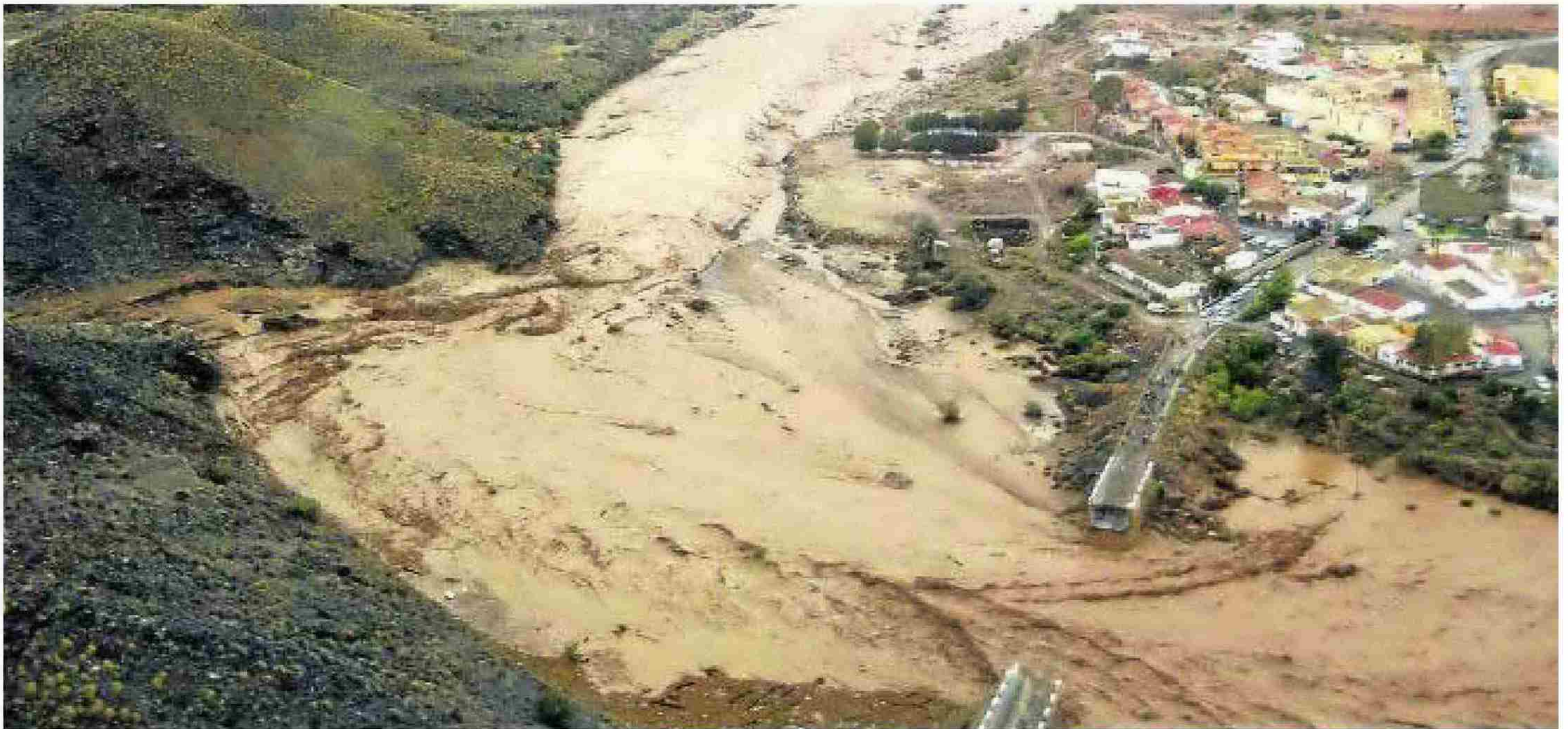
El río Antas desbordado a causa de las fuertes lluvias de finales de septiembre destruyó todo lo que encontró a su paso, incluido el puente. :: GUARDIA CIVIL
