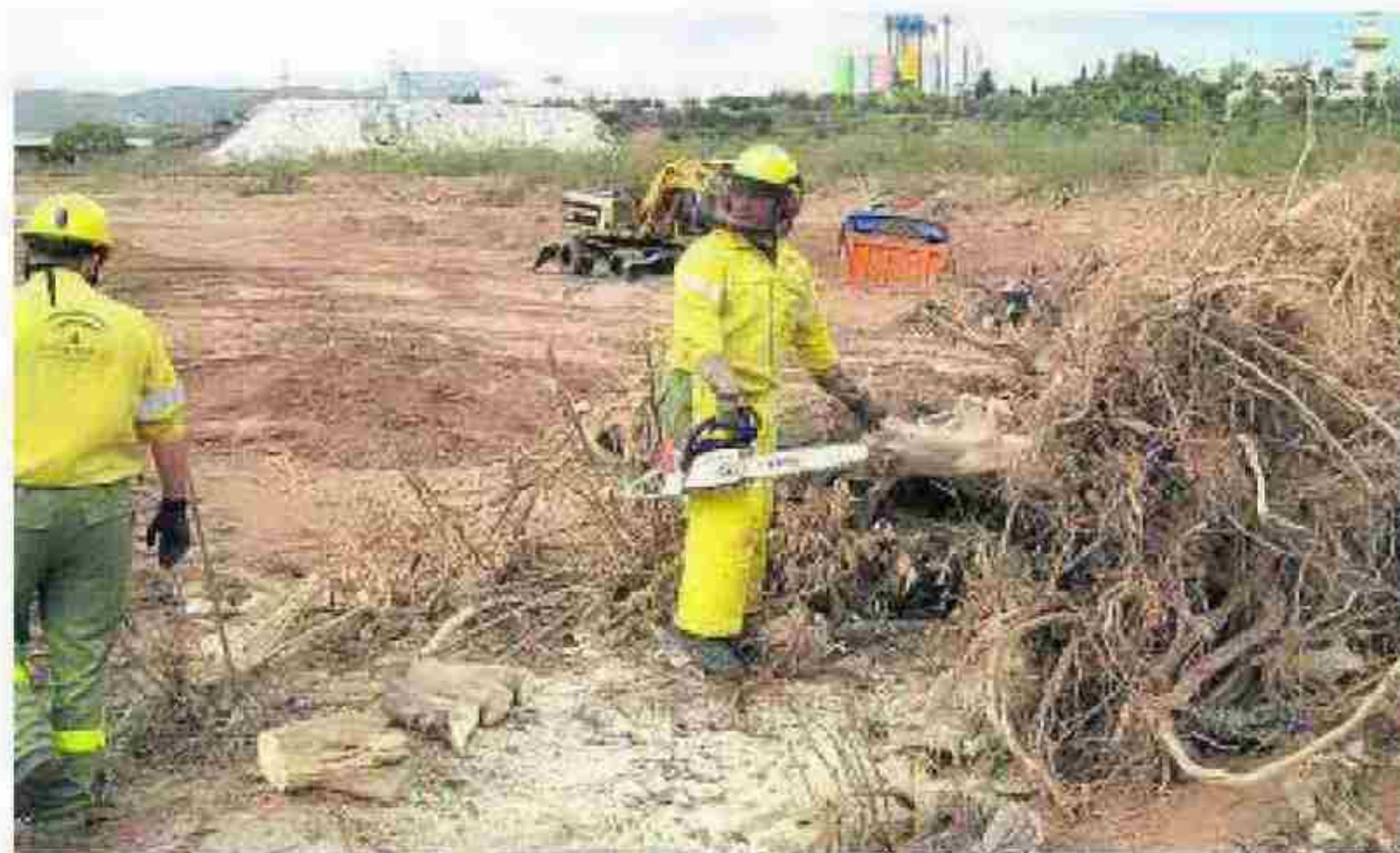
Trabajos de limpieza en el cauce del río Antas. :: IDEAL
