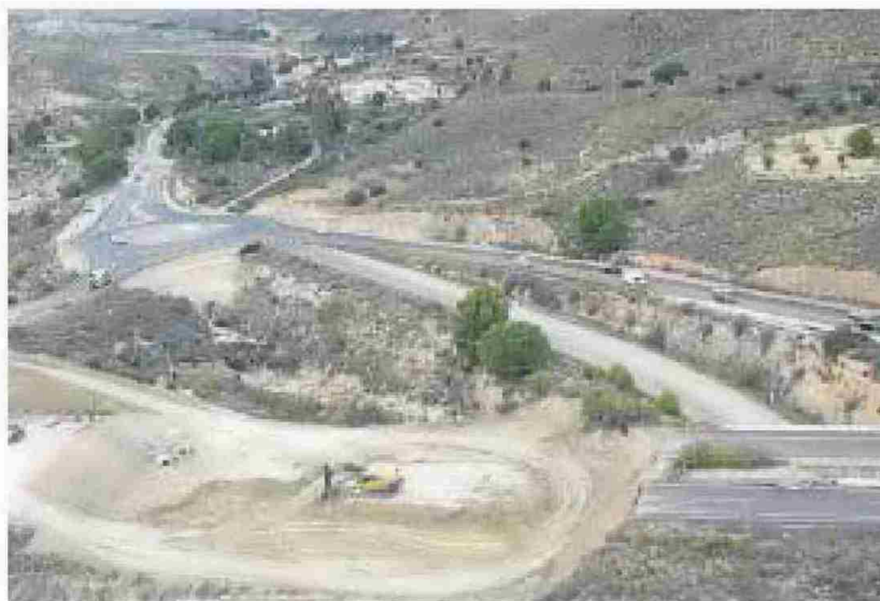
Puente y rotonda A-7, Sorbas.
