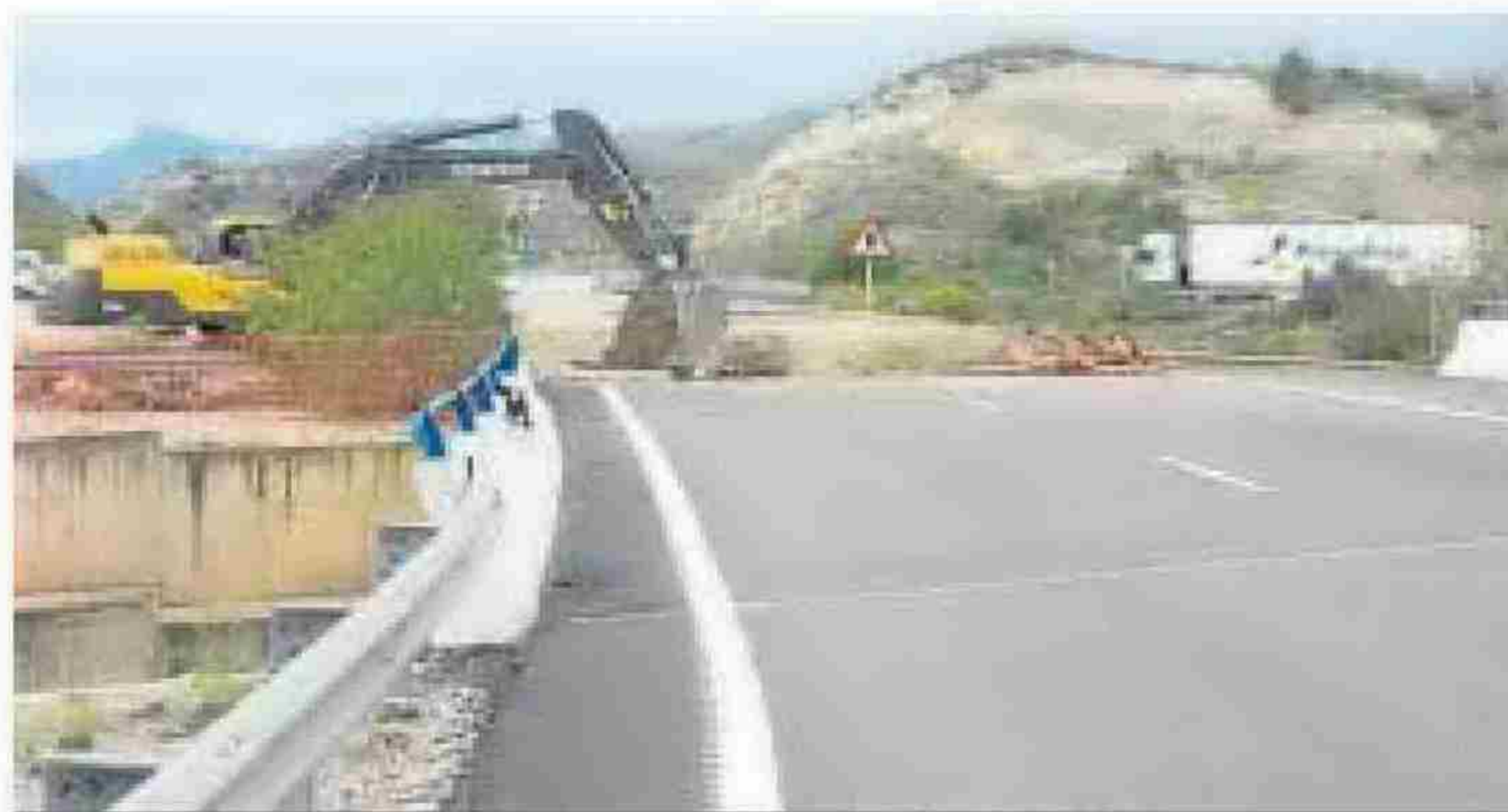
Obras de mejora en el PK 514.
