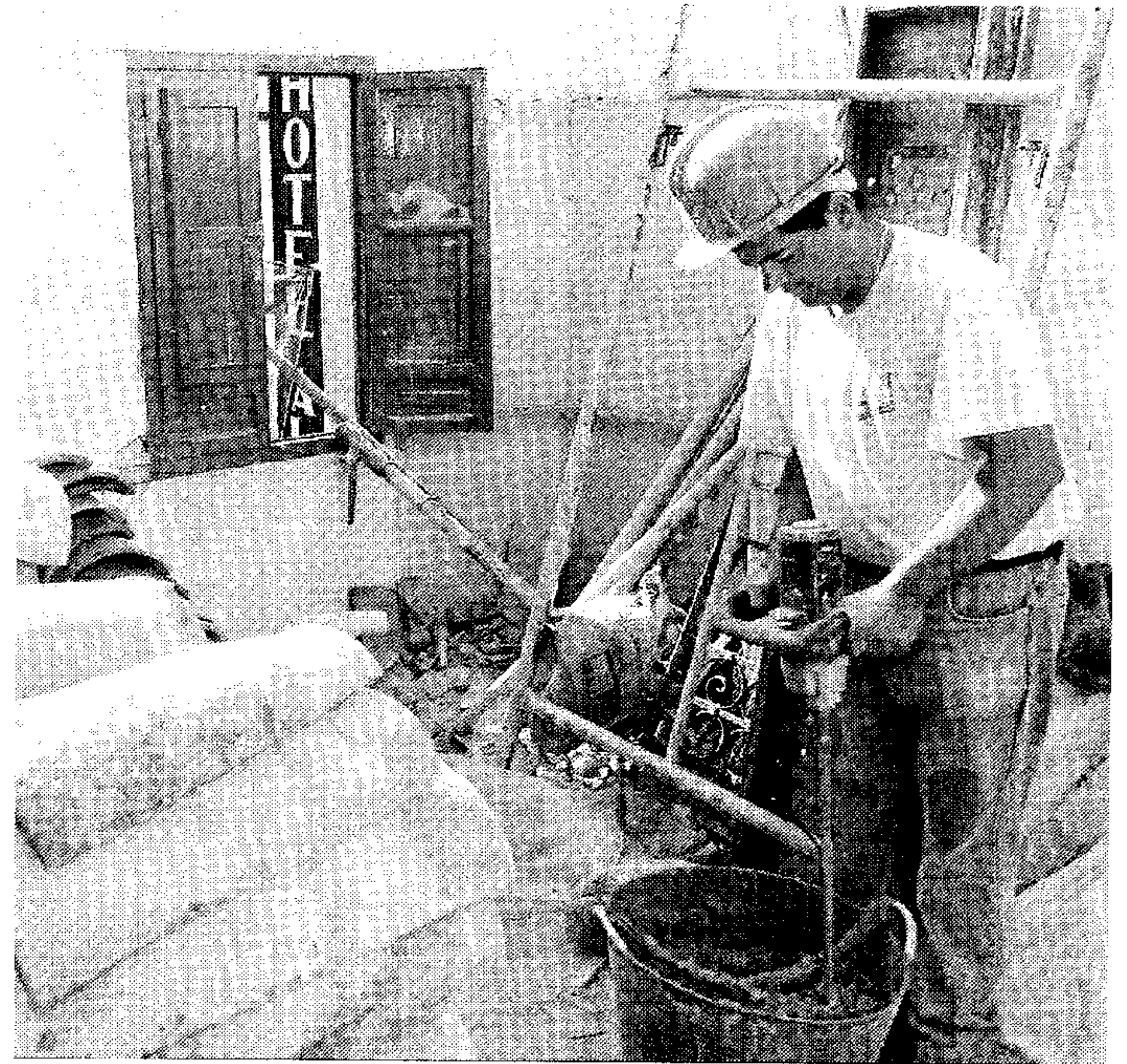
Un obrero trabaja en la rehabilitación de una vivienda.
