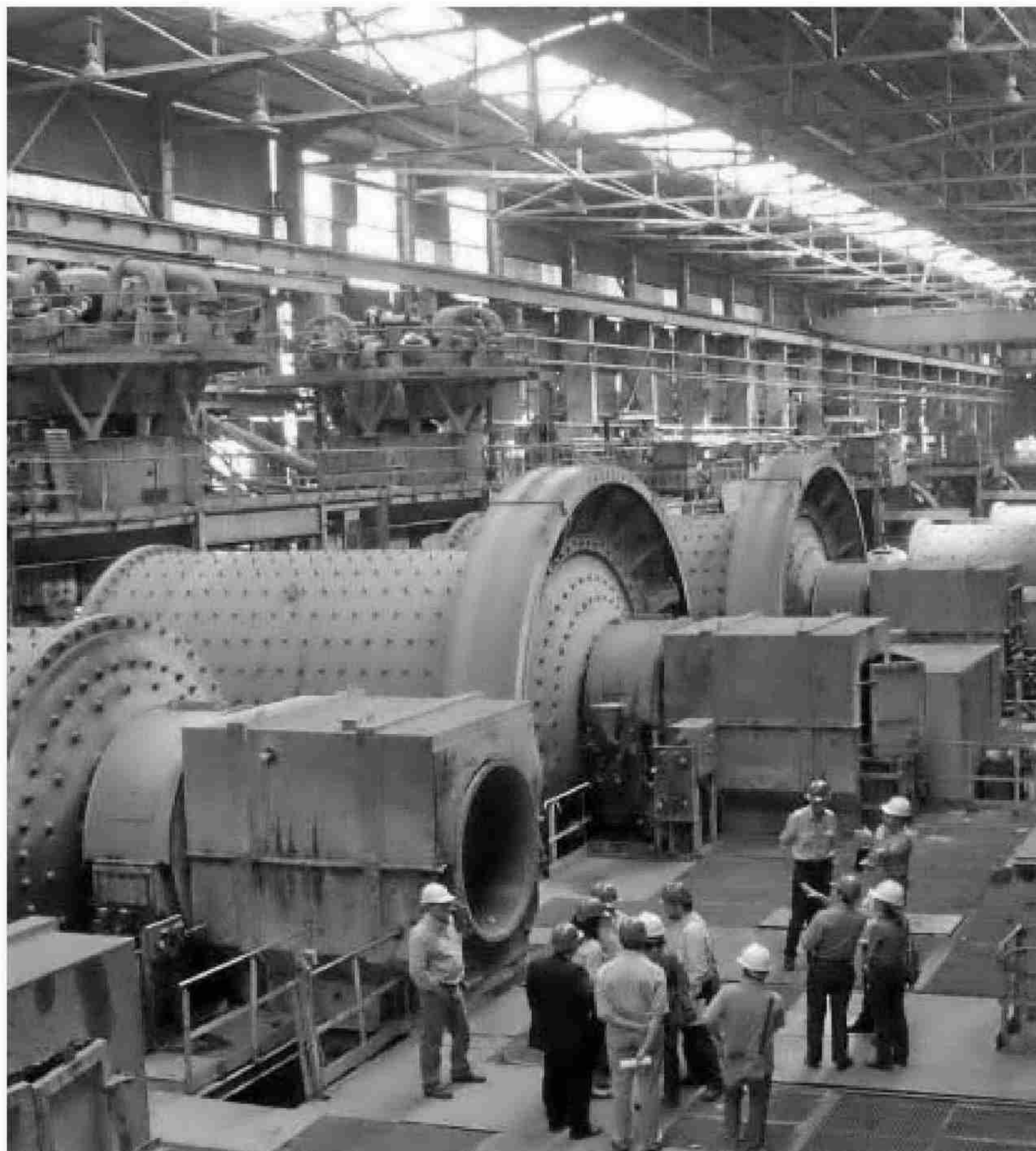
Planta de trituración del mineral de Emed Tartessus en Riotinto.
