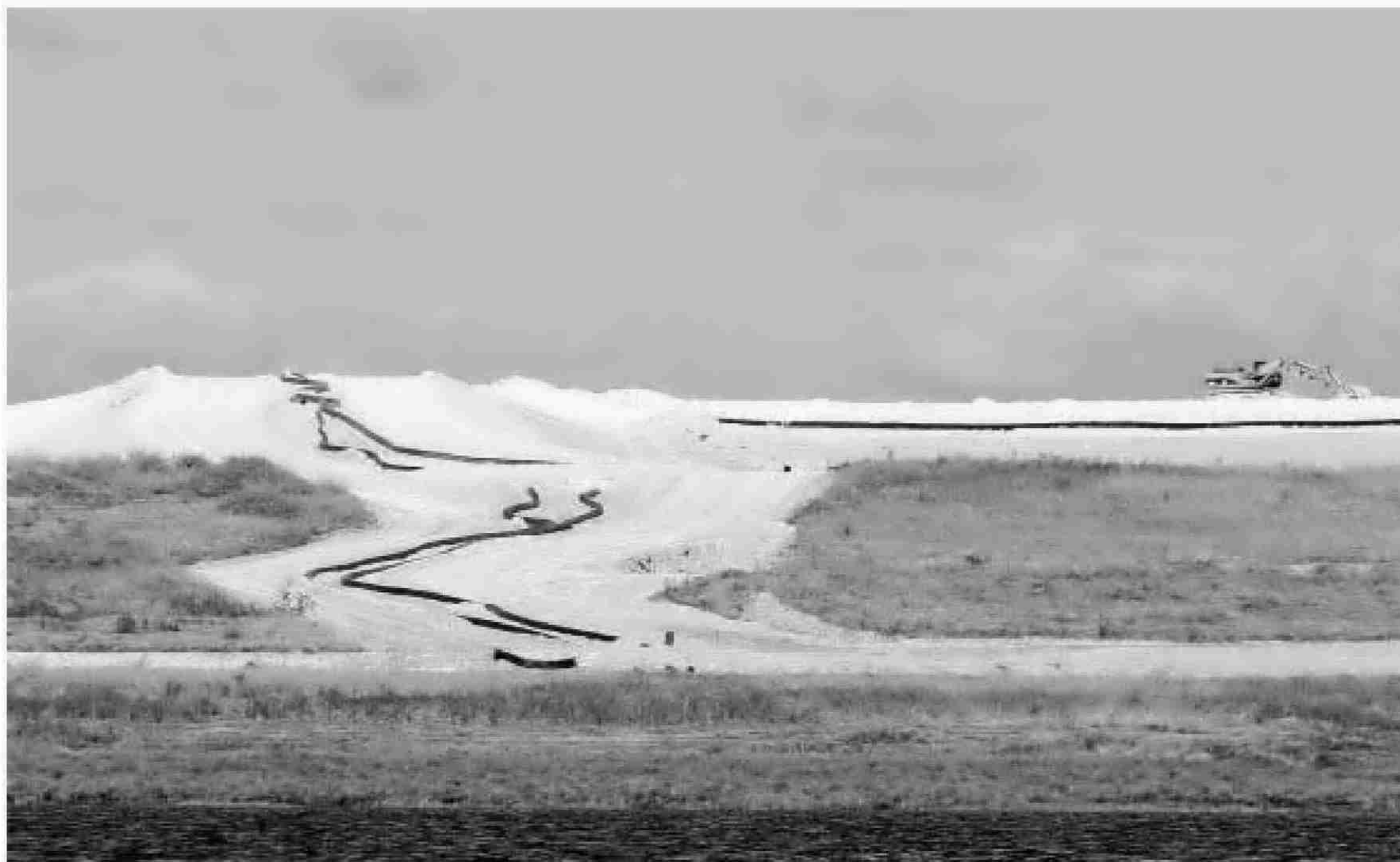
Vista parcial de las balsas de fosfoyesos depositadas a las afueras de Huelva desde el río Tinto a su llegada al estuario de la capital.
