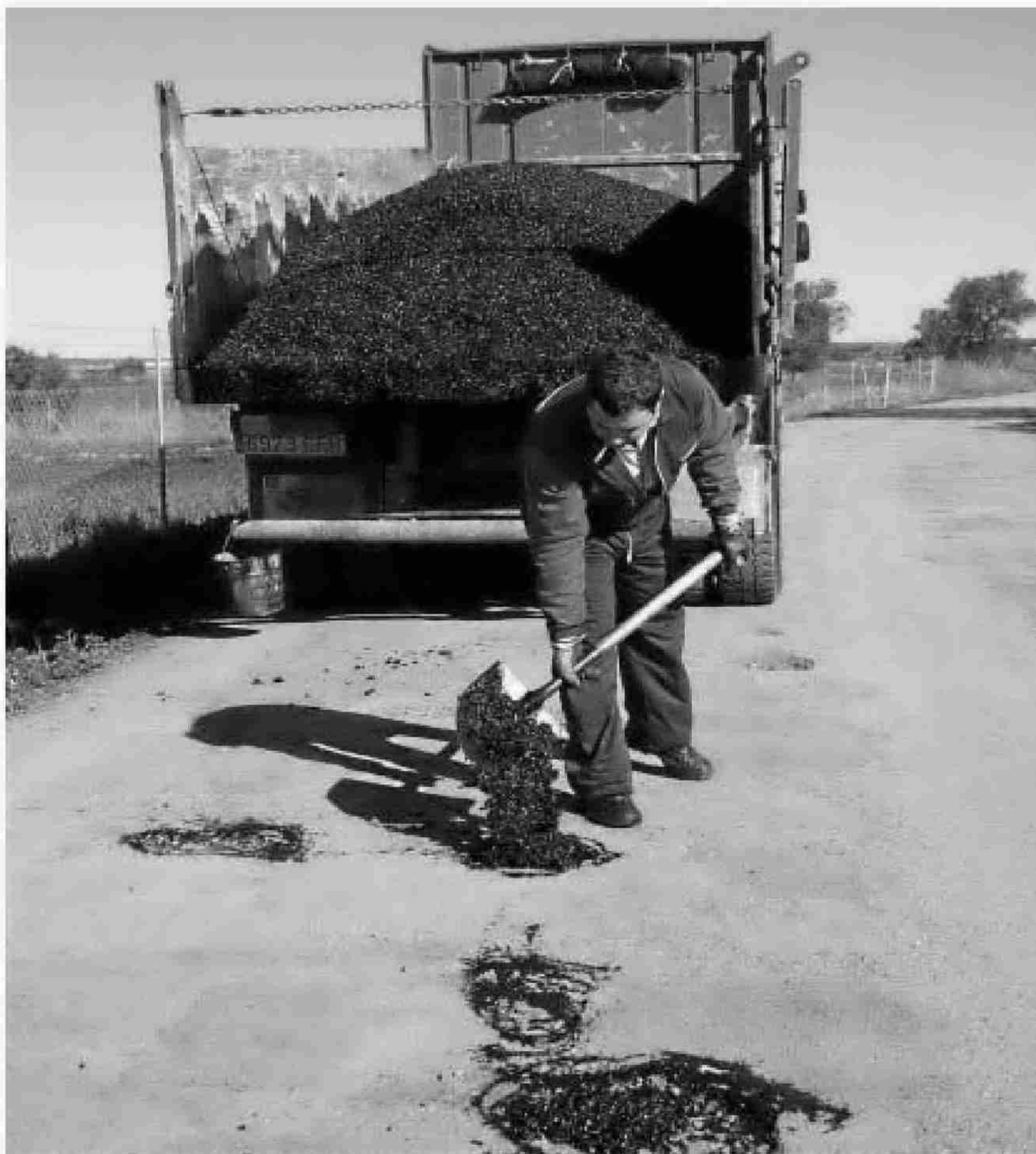
Un operario realiza obras de asfaltado en un camino rural de la provincia onubense.
