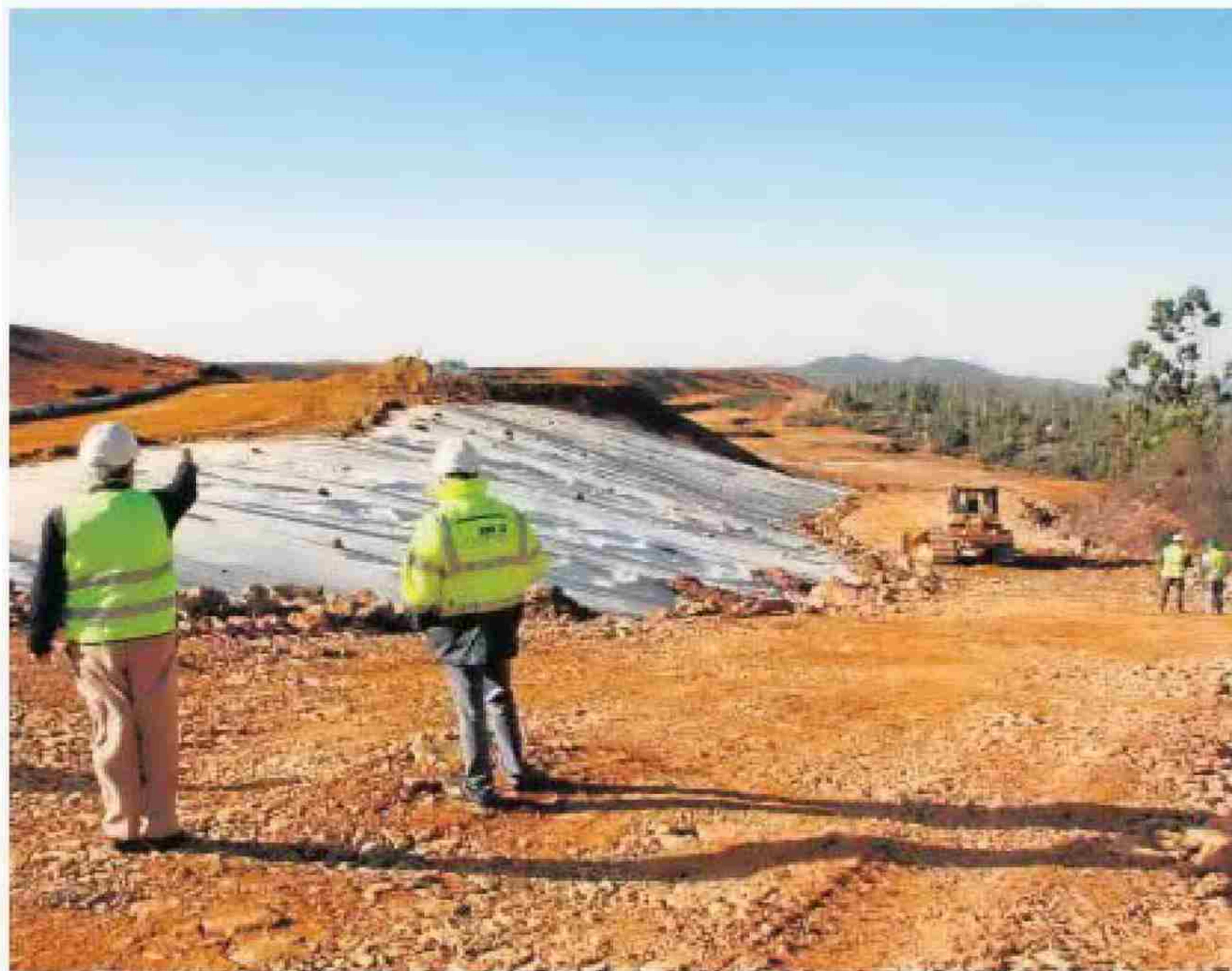
Los trabajos requieren maquinaria pesada y una decena de obreros.
