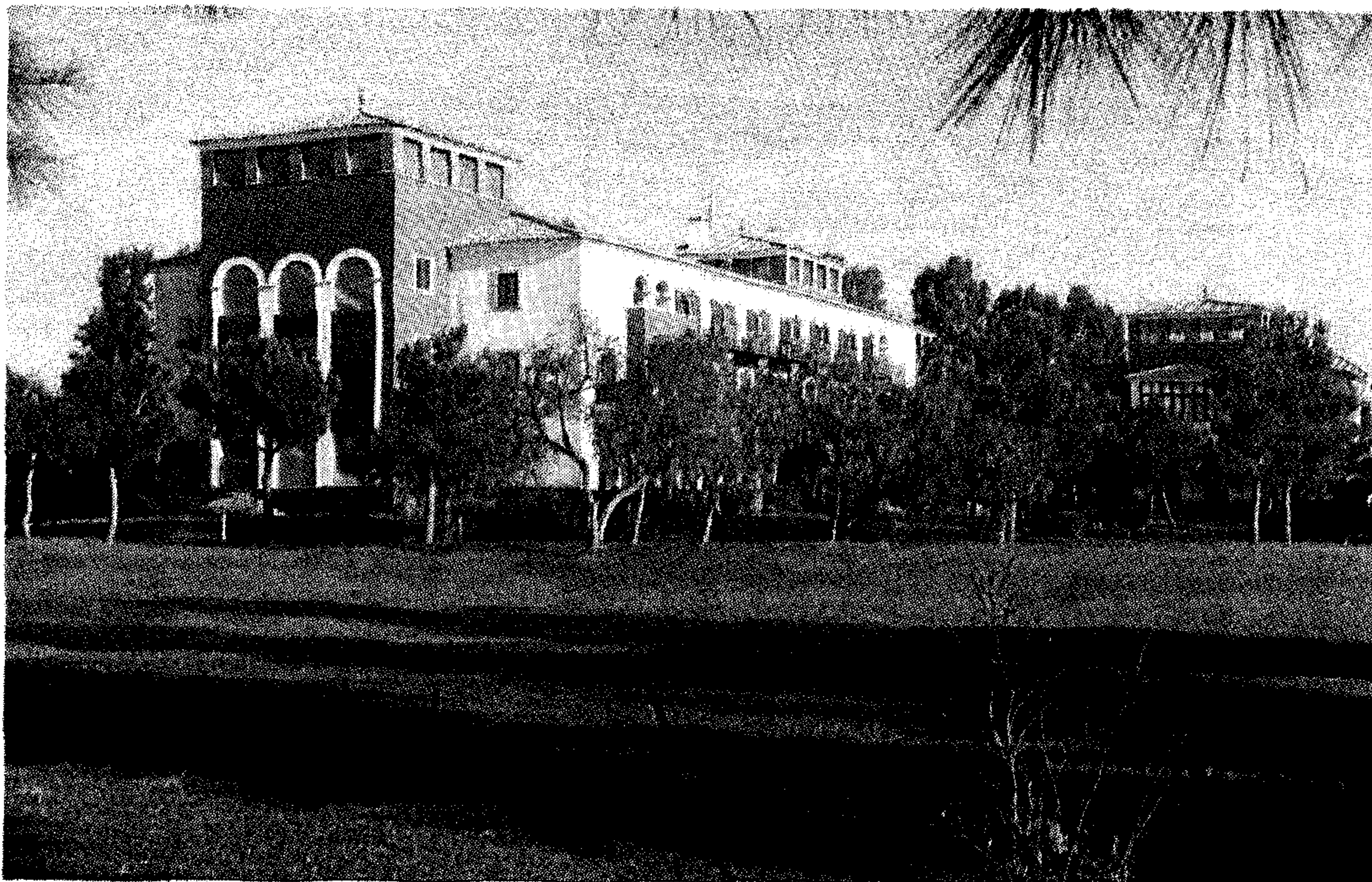
Instalaciones del hotel Vincci en Isla Canela.
