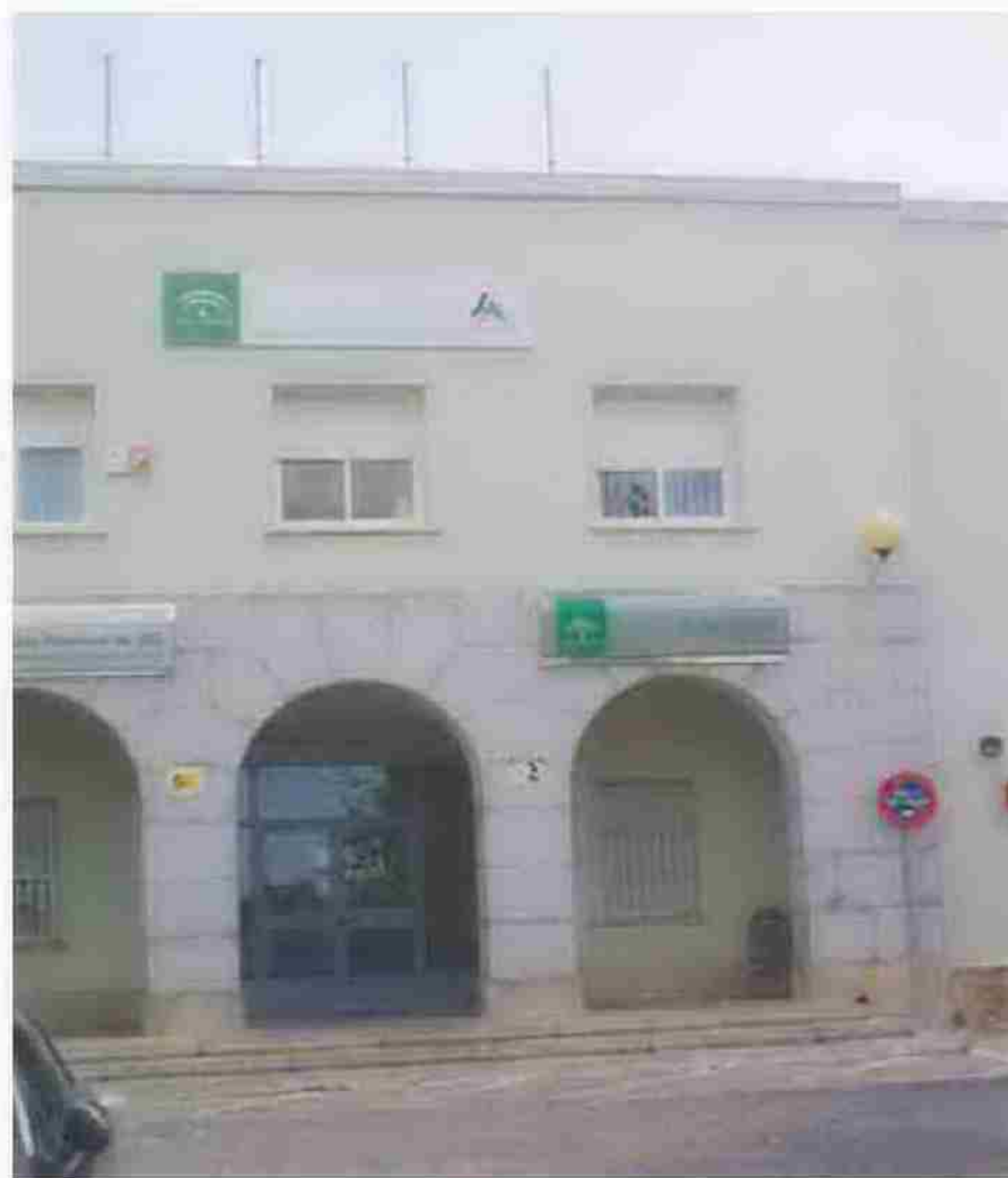
Fachada principal del edificio del Distrito Huelva-Costa. VH
