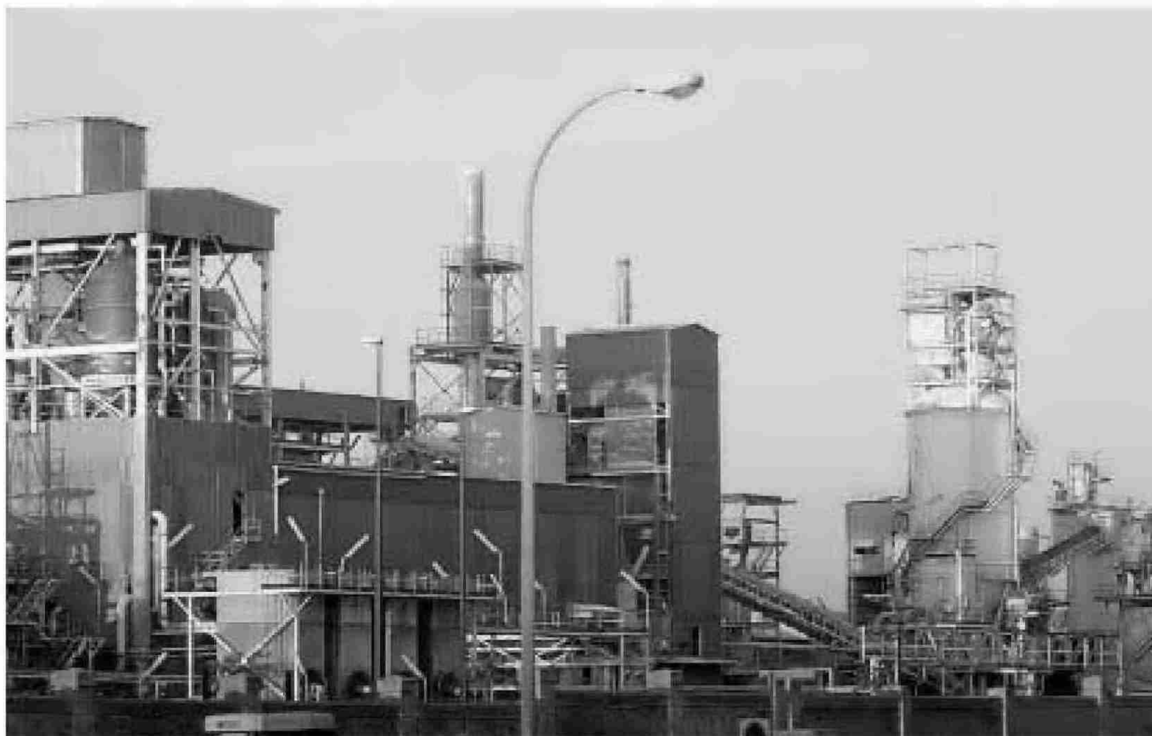
Instalaciones de Foret en la avenida Francisco Montenegro.
