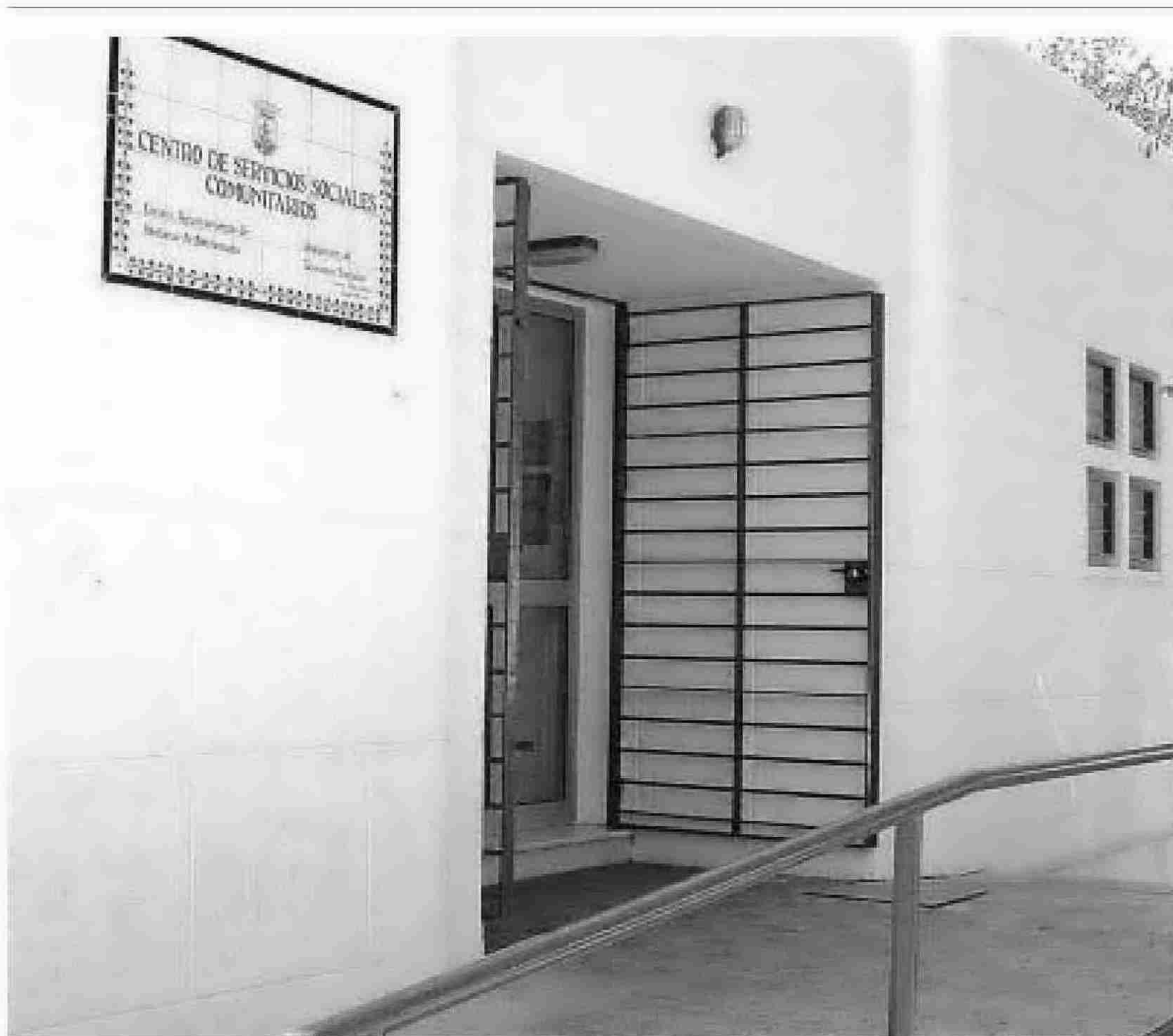
Fachada de un centro de servicios sociales comunitarios de la Junta de Andalucía.
