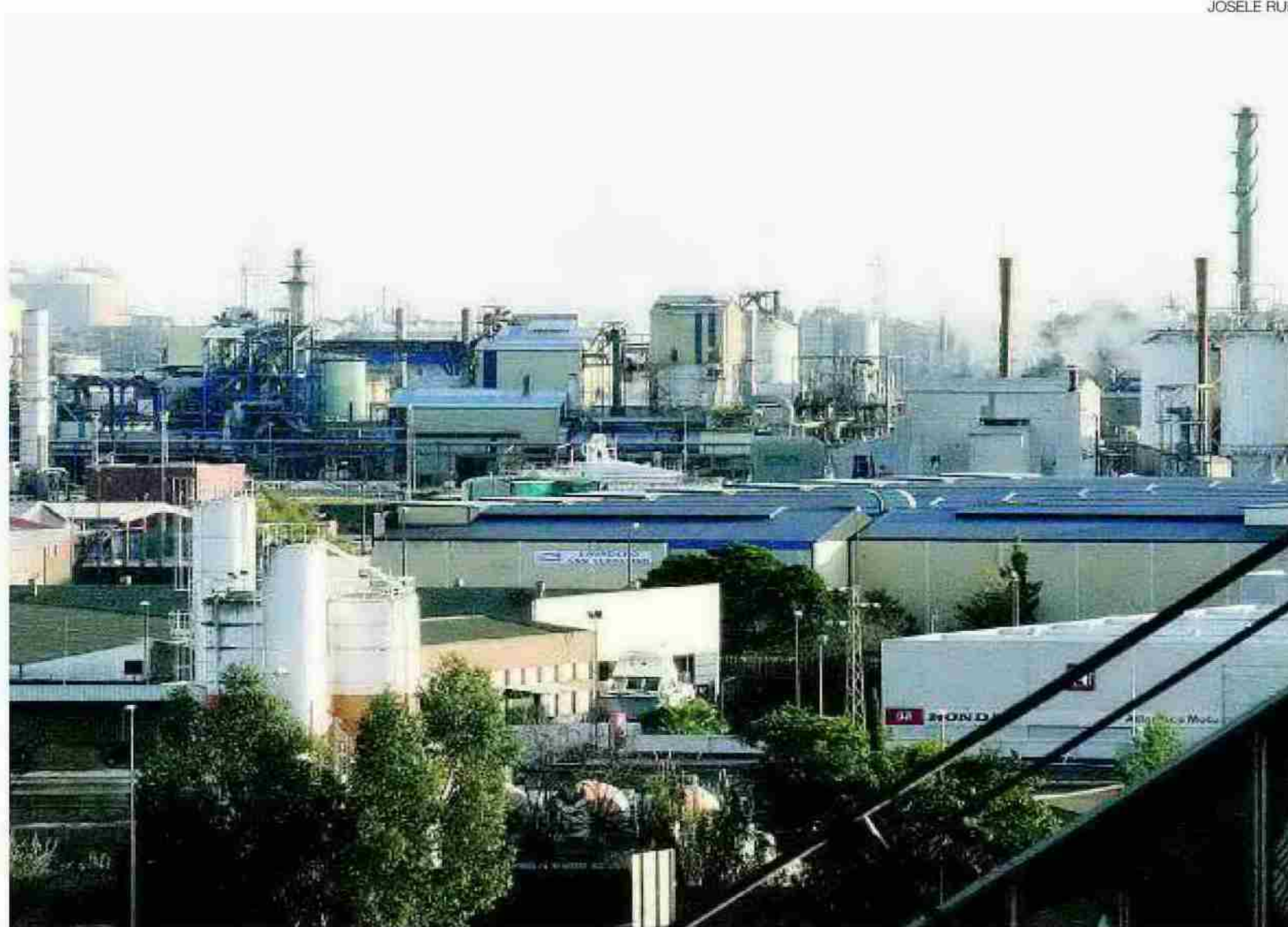
►► Panorámica de las industrias de la avenida Francisco Montenegro.
