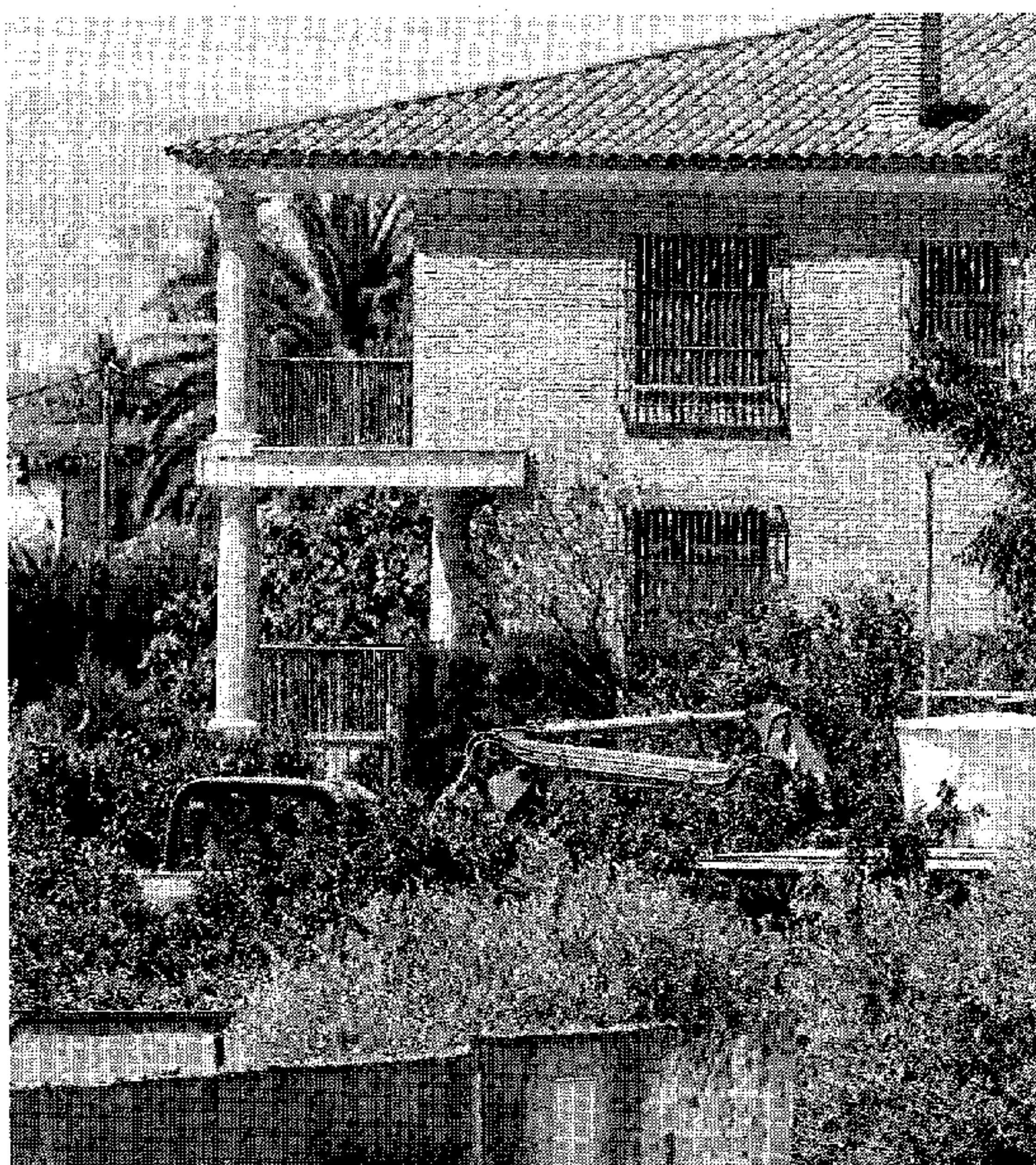
Una excavadora remueve el terreno de la zona posterior de la casa.
