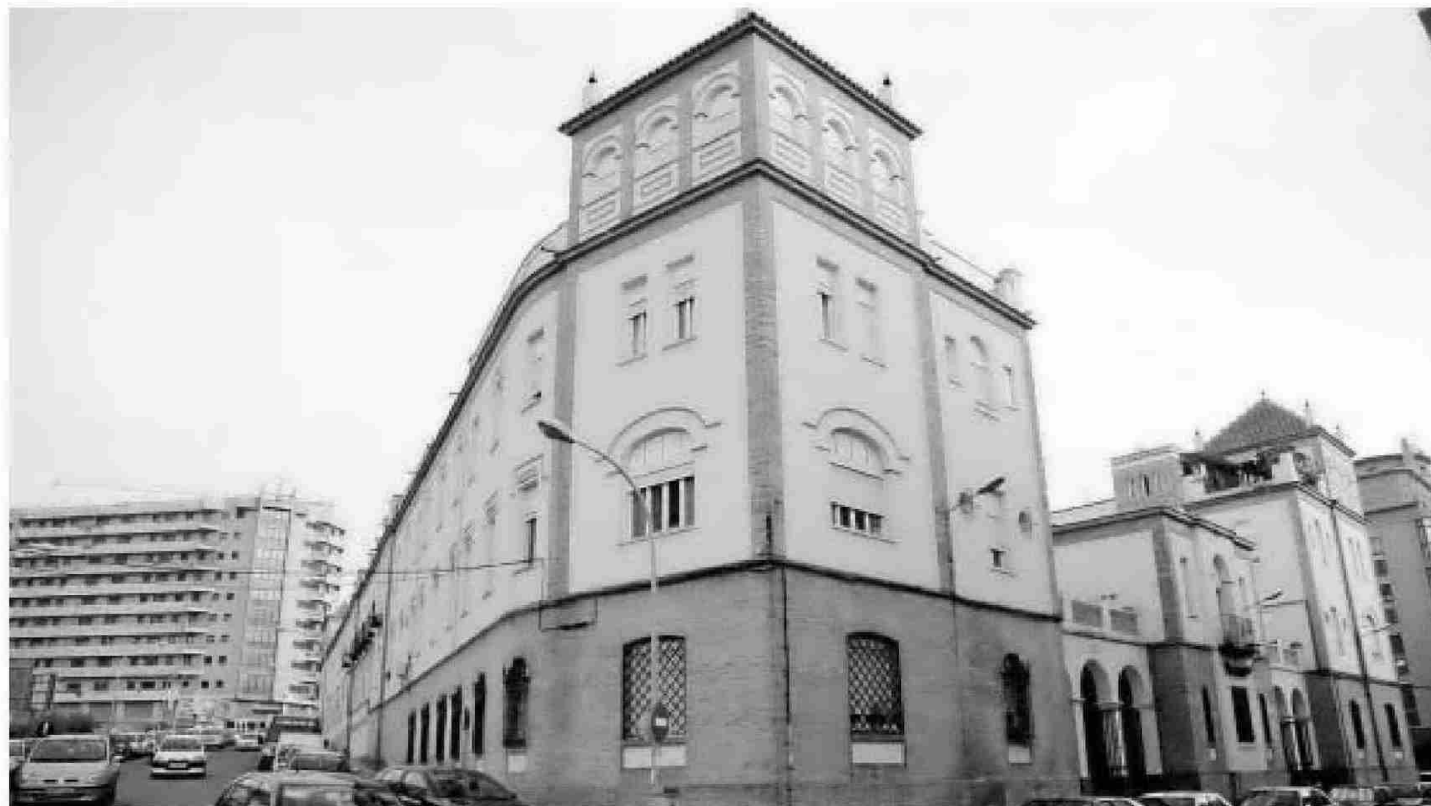
Bloque de viviendas sociales del Ayuntamiento en régimen de alquiler situadas en el Paseo de Buenos Aires de la capital.
