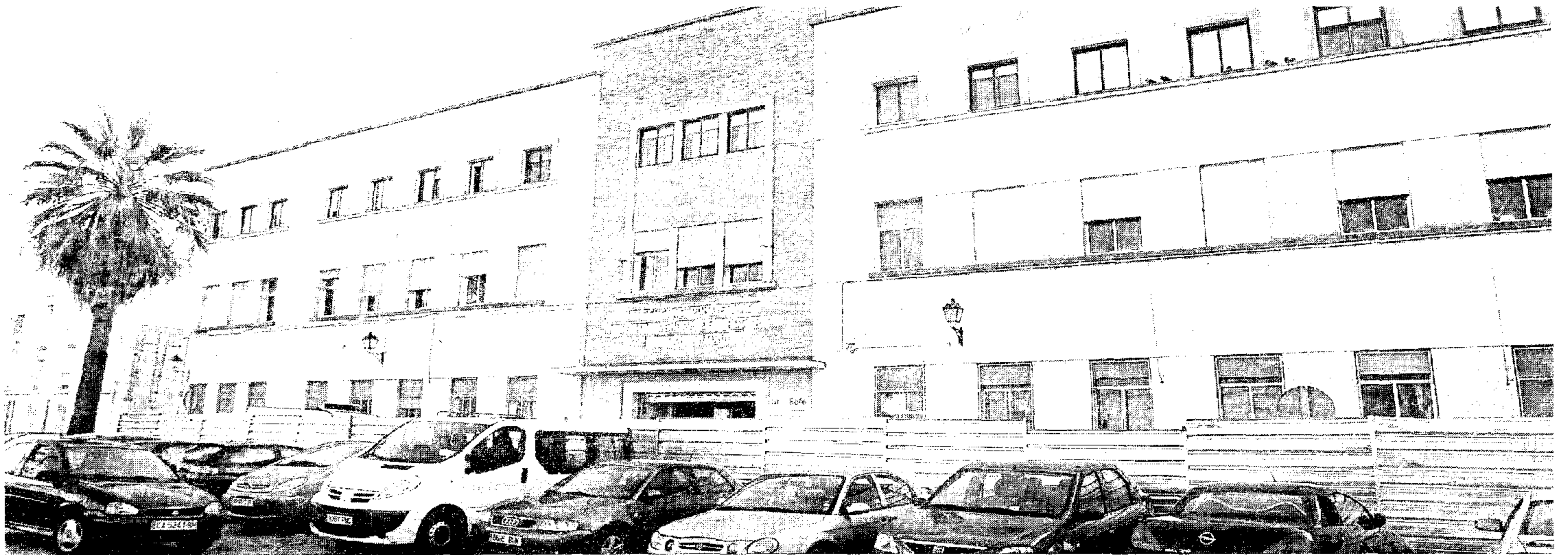
La fachada principal del colegio de la Viña, que acogerá a alumnos de Secundaria, Bachillerato y PCPI.
